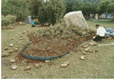
左上圖~隔草板設置時的情況(垂直深度15CM) 右上圖~隔草板施作完成且石頭重新排列 並於竹叢上堆置新土與肥料
