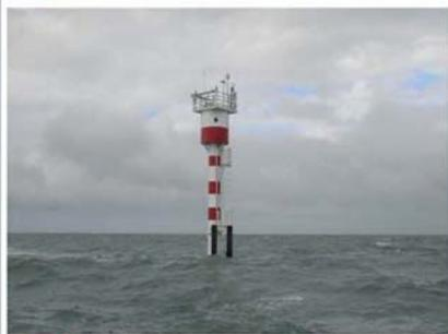
海上觀測塔:本觀測塔塔體為鋼鐵材料,直徑2.0m,上置觀測平台,水下可佈雷聲,安置觀測儀器,結合GPS無線傳輸方式,傳送觀測資料。目前,本所海風技術研究中心於臺北港外海水深-20m處,及安平港外海水深-15m處各設置海上觀測塔乙座
