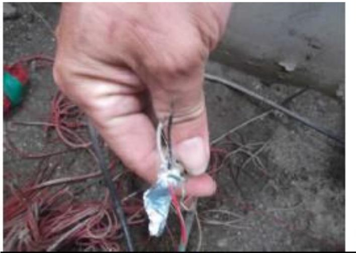
圖 4-5 東沙海巡署辦公室旁電信箱內水溫計線路被剪斷情形
