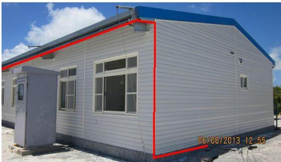
圖 4-2 潮位站管線布設示意圖
