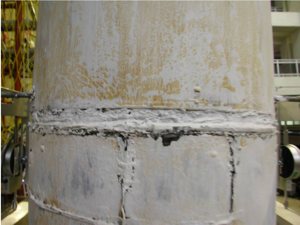
照片 3.99 試體 3 第二、三節塊間混凝土裂縫長度( \theta = +0.06 弧度)
