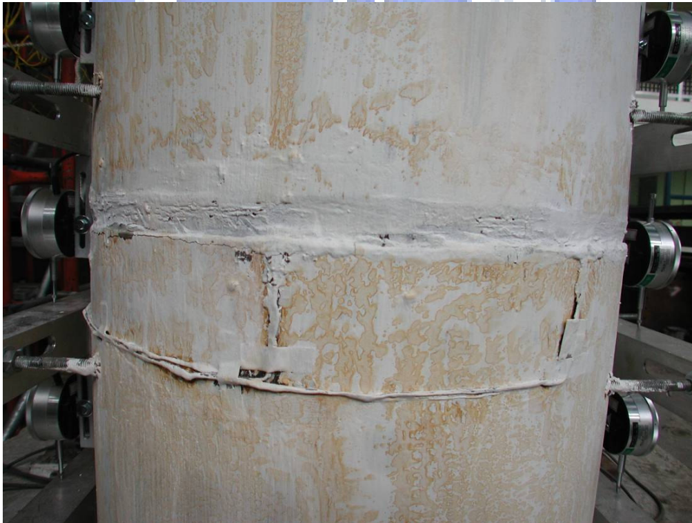
照片 3.74 試體 3 第一、二節塊間混凝土裂縫長度( \theta = +0.02 弧度)
