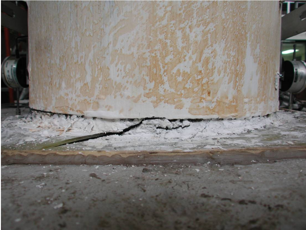
照片 3.89 試體 3 第一節塊柱底混凝土裂縫長度( \theta = +0.05 弧度)
