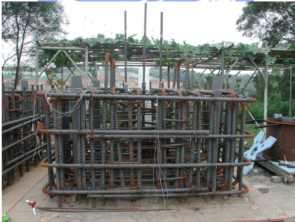
照片 3.6 試體 2 基礎鋼筋籠
