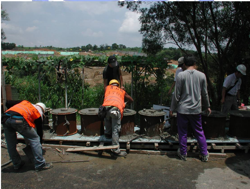
照片 3.10 鋼管混凝土節塊澆置
