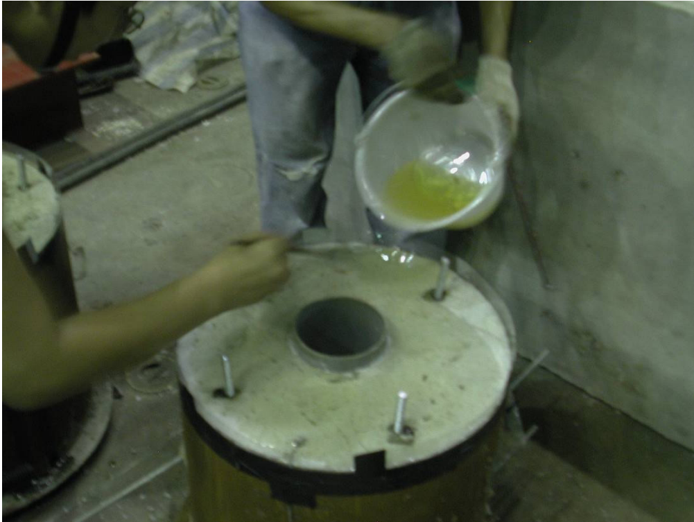
照片 3.11 高流動性環氧樹脂在節塊上施工情形
