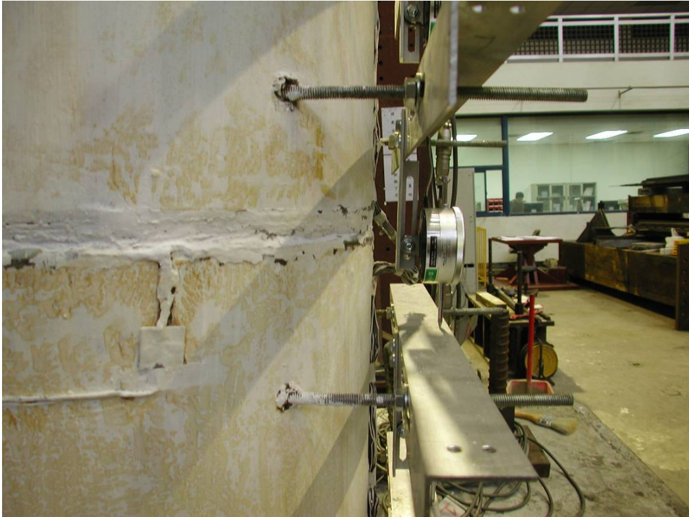
照片 3.101 第一、二節塊間鋼套管邊緣有少許變形現象
