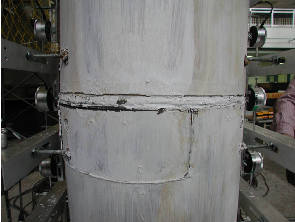
照片 3.45 試體 2 第一、二節塊間混凝土裂縫長度( \theta = +0.04 弧度)
