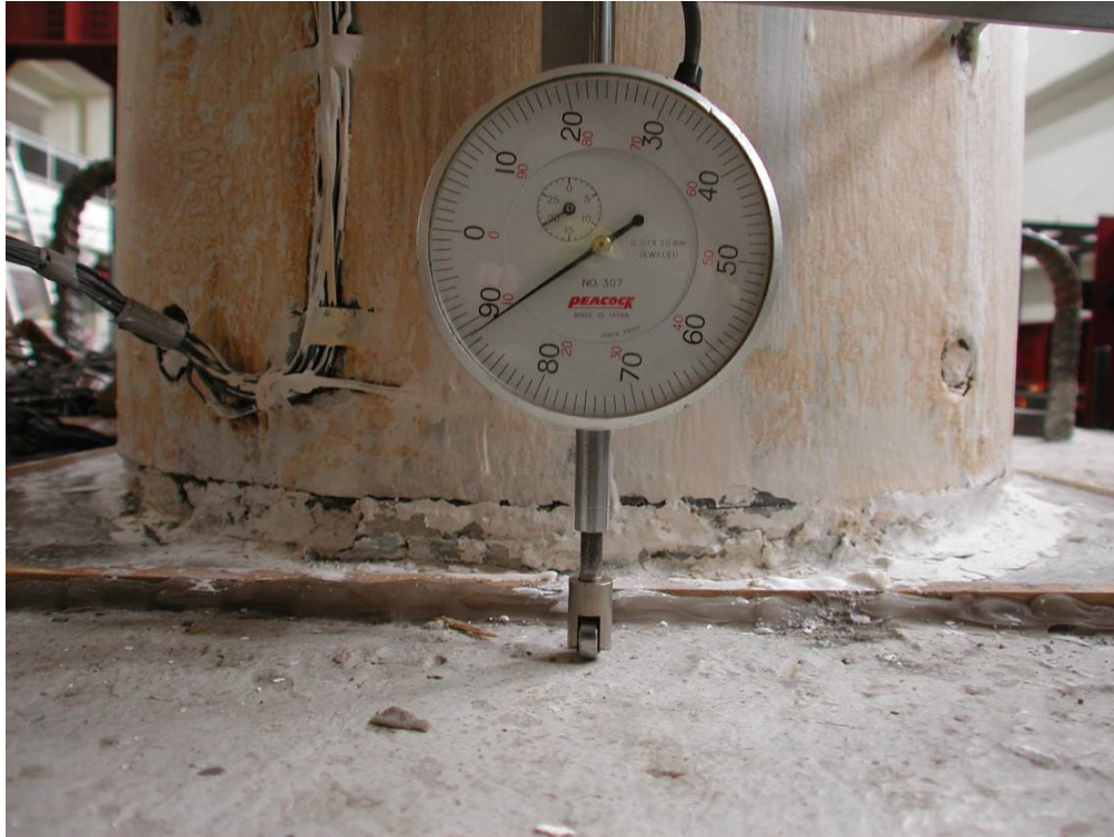
照片 3.63 試體 3 第一節塊柱底撓曲裂縫( \theta = +0.009 弧度)
