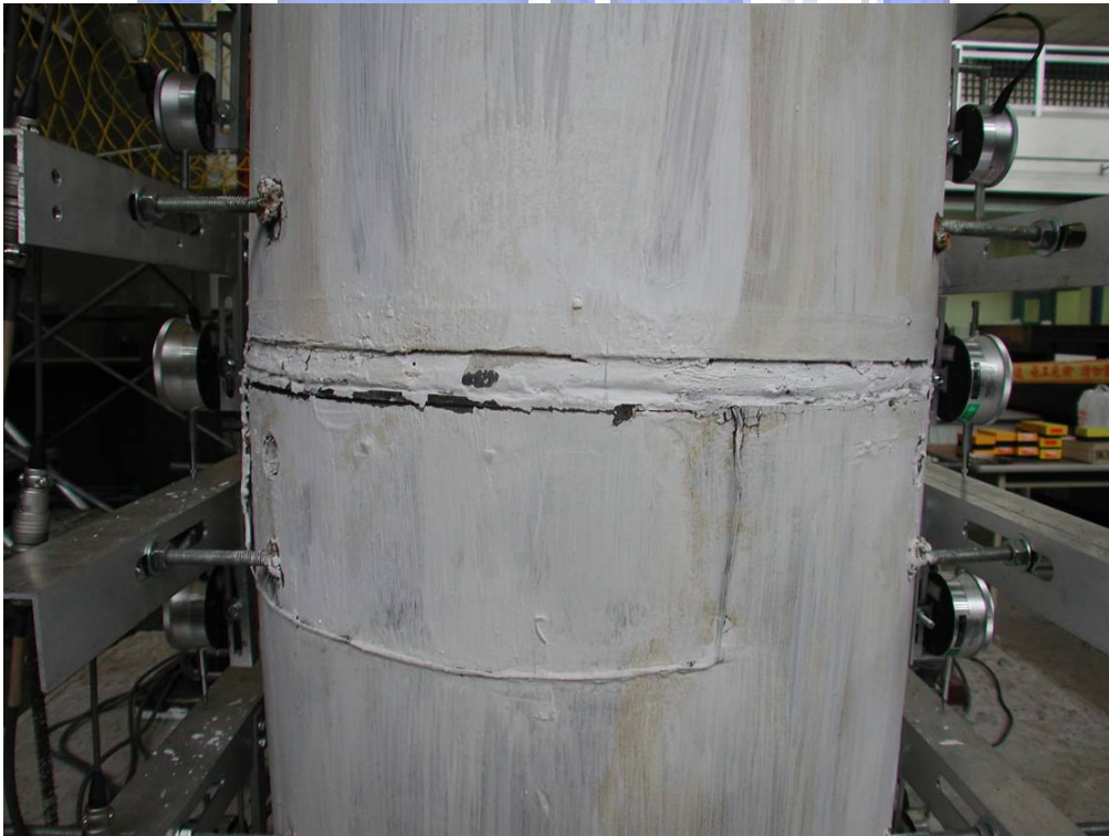
照片 3.40 試體 2 第一、二節塊間混凝土裂縫長度( \theta = +0.03 弧度)
