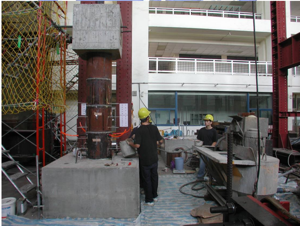
照片 3.24 節塊內套管高壓力灌漿施工情形
