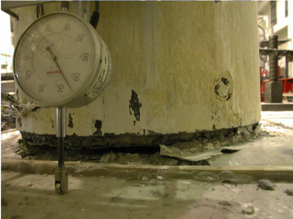
照片 3.102 試驗後第一節塊柱底混凝土嚴重破壞
