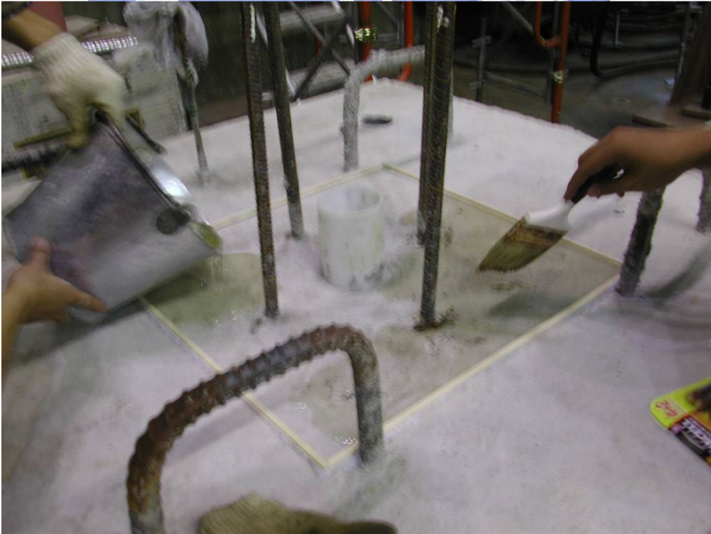
照片 3.12 高流動性環氧樹脂在基礎面上施工情形
