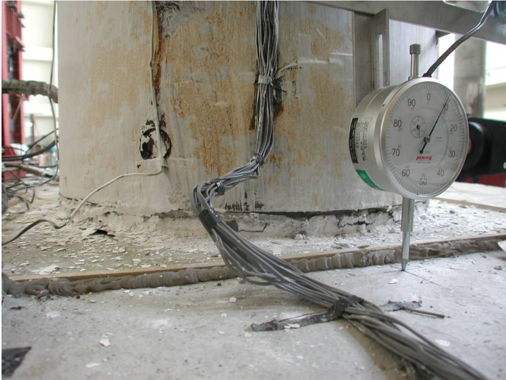
照片 3.53 試體 2 第一節塊柱底撓曲裂縫( \theta = +0.06 弧度)
