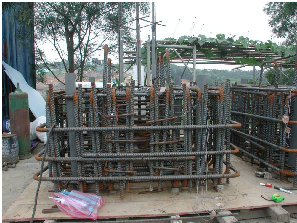
照片 3.7 試體 3 基礎鋼筋籠
