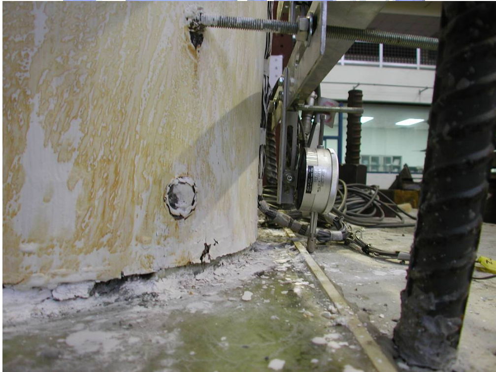
照片 3.100 第一節塊柱底鋼套管邊緣有少許變形現象
