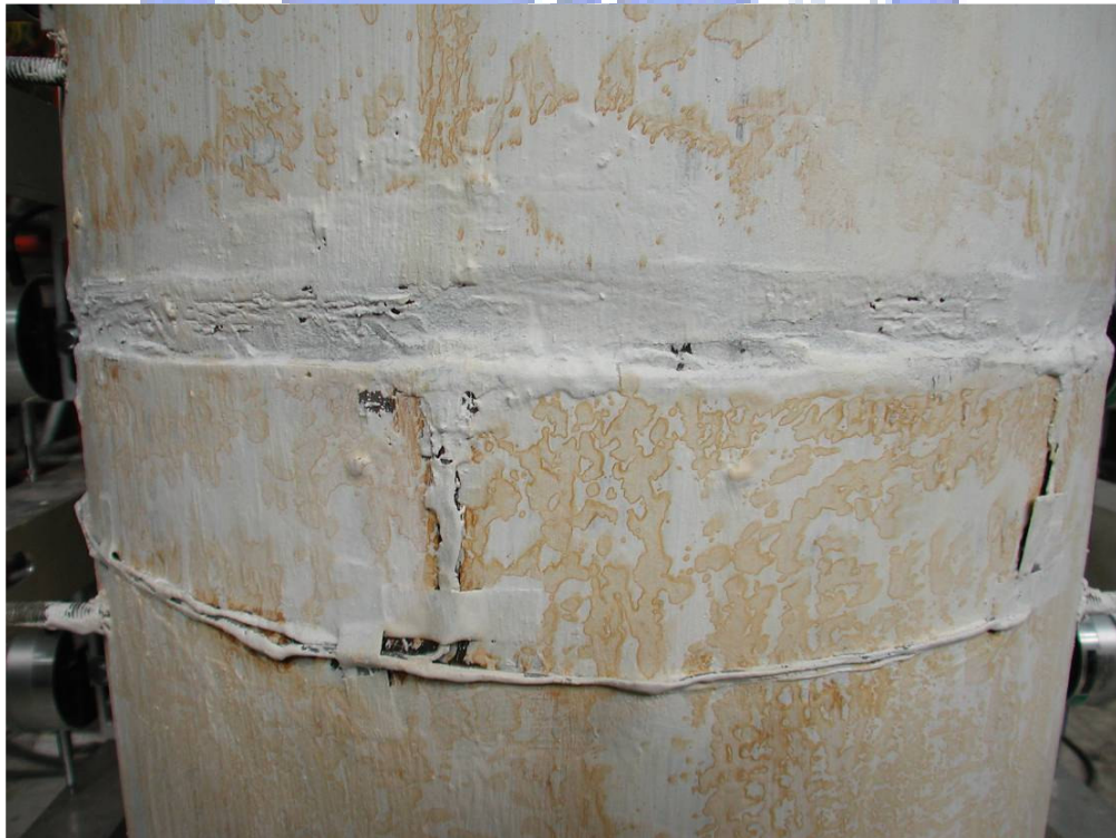
照片 3.66 試體 3 第一、二節塊間混凝土裂縫長度( \theta = +0.009 弧度)
