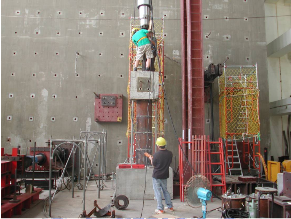
照片 3.23 吊裝油壓千斤頂並施加預力
