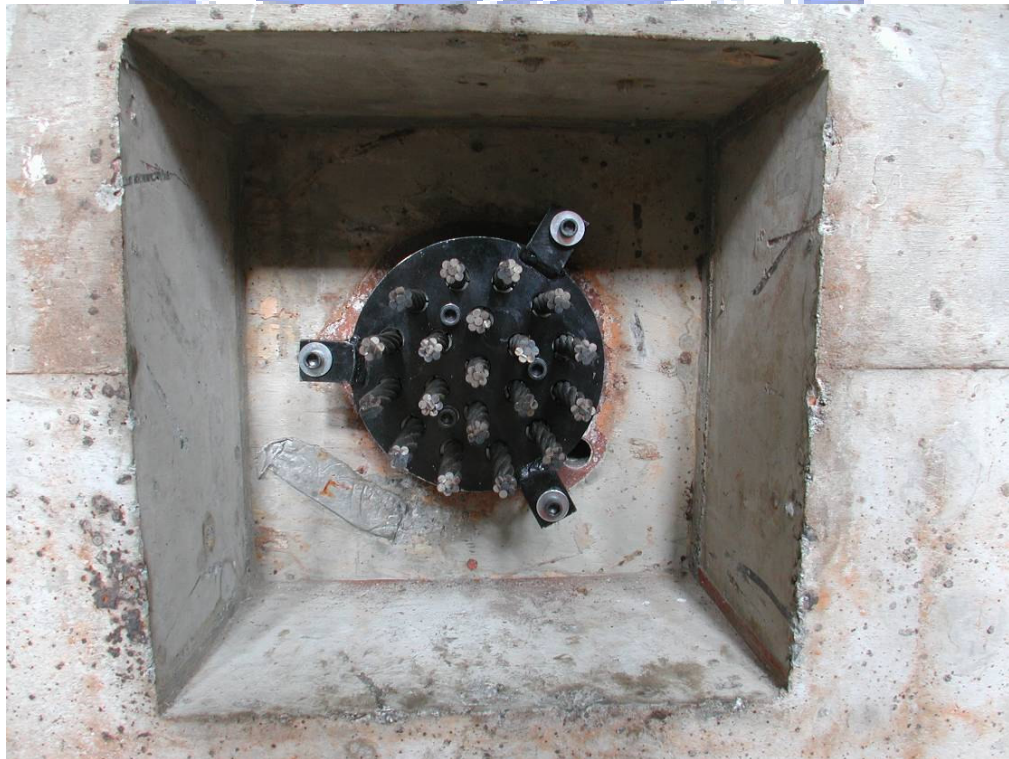
照片 3.14 鋼絞線固定於基礎底部的情形
