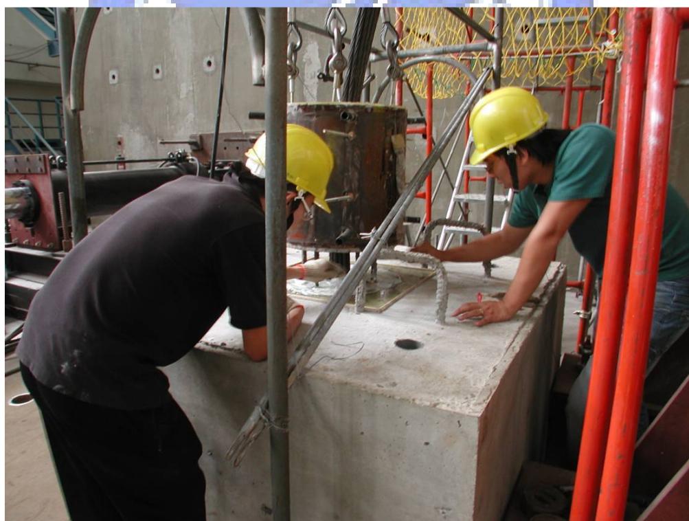
照片 3.16 基礎面上塗抹低流動性環氧樹脂
