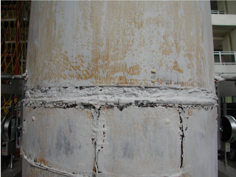
照片 3.87 試體 3 第二、三節塊間混凝土裂縫長度( \theta = +0.04 弧度)
