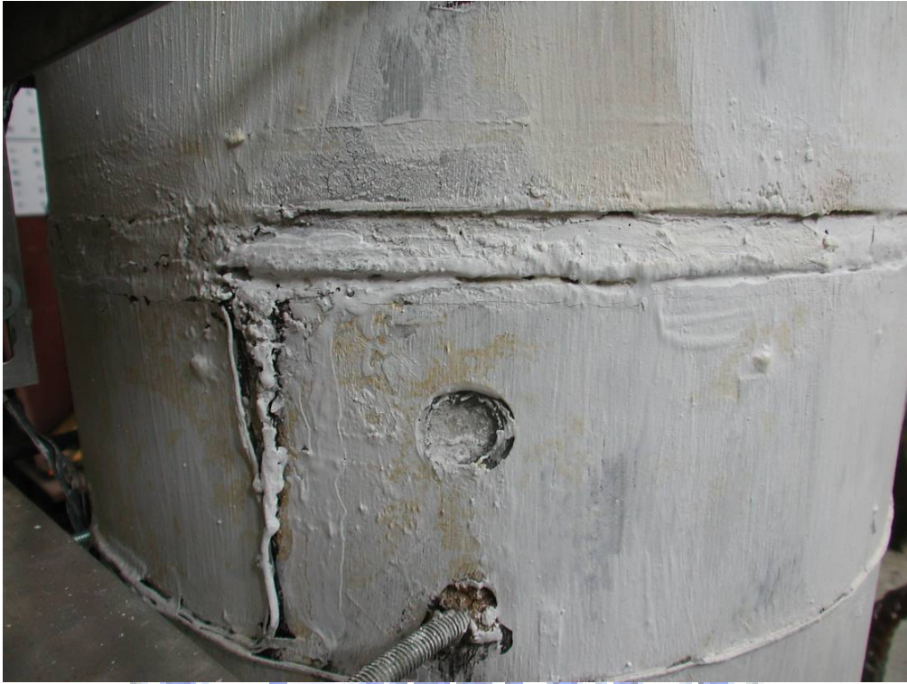
照片 3.27 試體 2 第一、二節塊間裂痕產生( \theta = +0.006 弧度)
