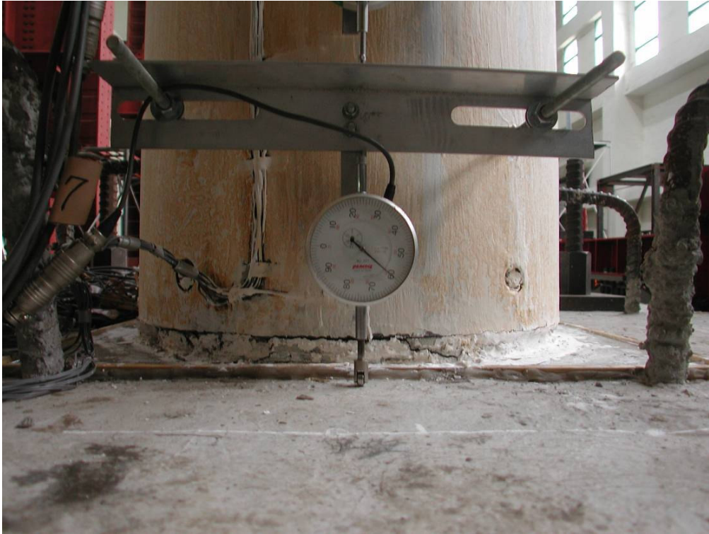
照片 3.67 試體 3 第一節塊柱底撓曲裂縫( \theta = +0.015 弧度)
