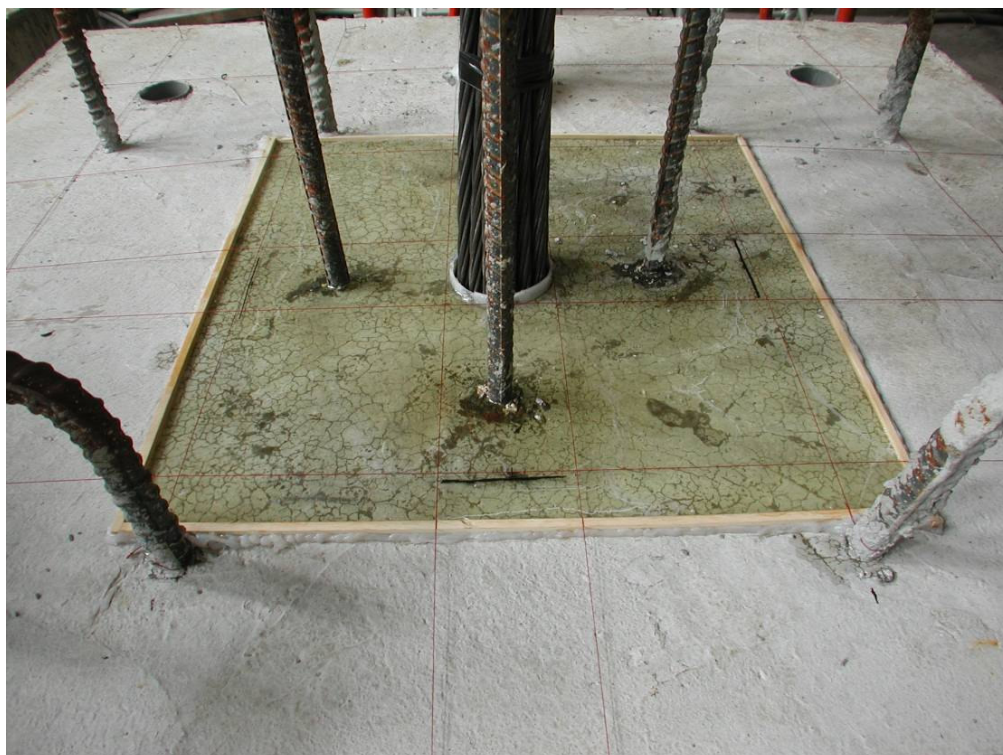
照片 3.15 在基礎面上放樣節塊的位置
