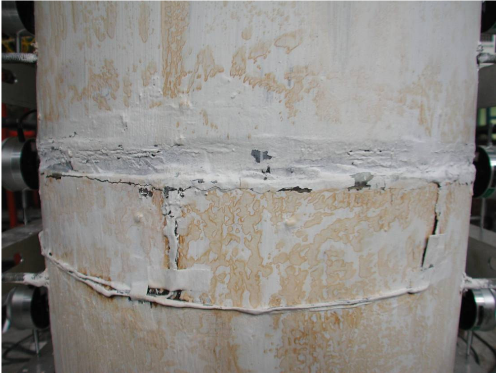
照片 3.91 試體 3 第一、二節塊間混凝土裂縫長度( \theta = +0.05 弧度)
