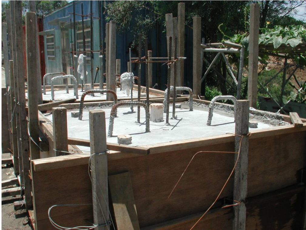
照片 3.9 基礎混凝土澆置
