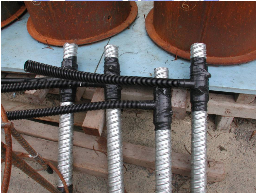
照片 3.2 螺紋套管與灌漿管
