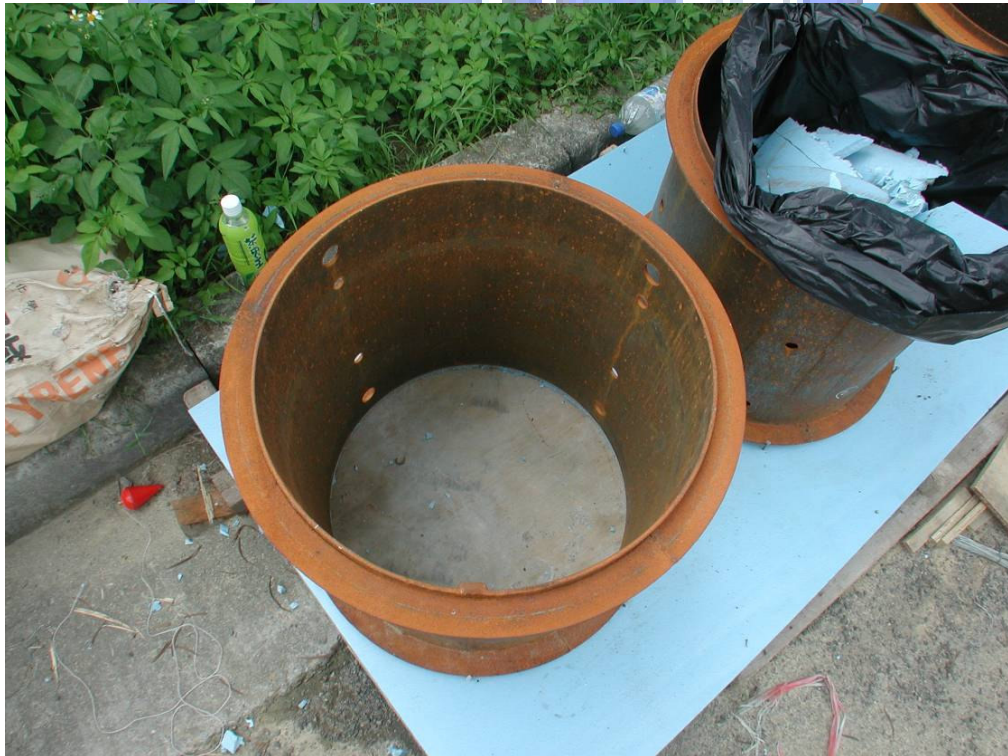
照片 3.4 混凝土節塊底部模板施工
