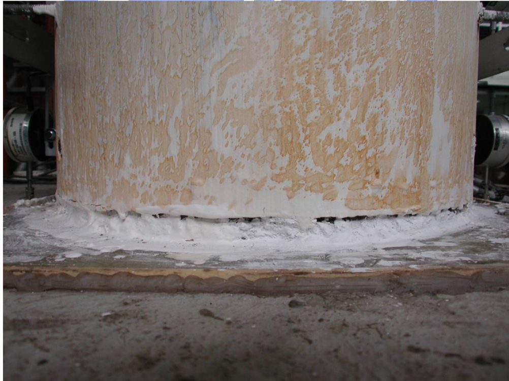
照片 3.64 試體 3 第一節塊柱底混凝土裂縫長度( \theta = +0.009 弧度)
