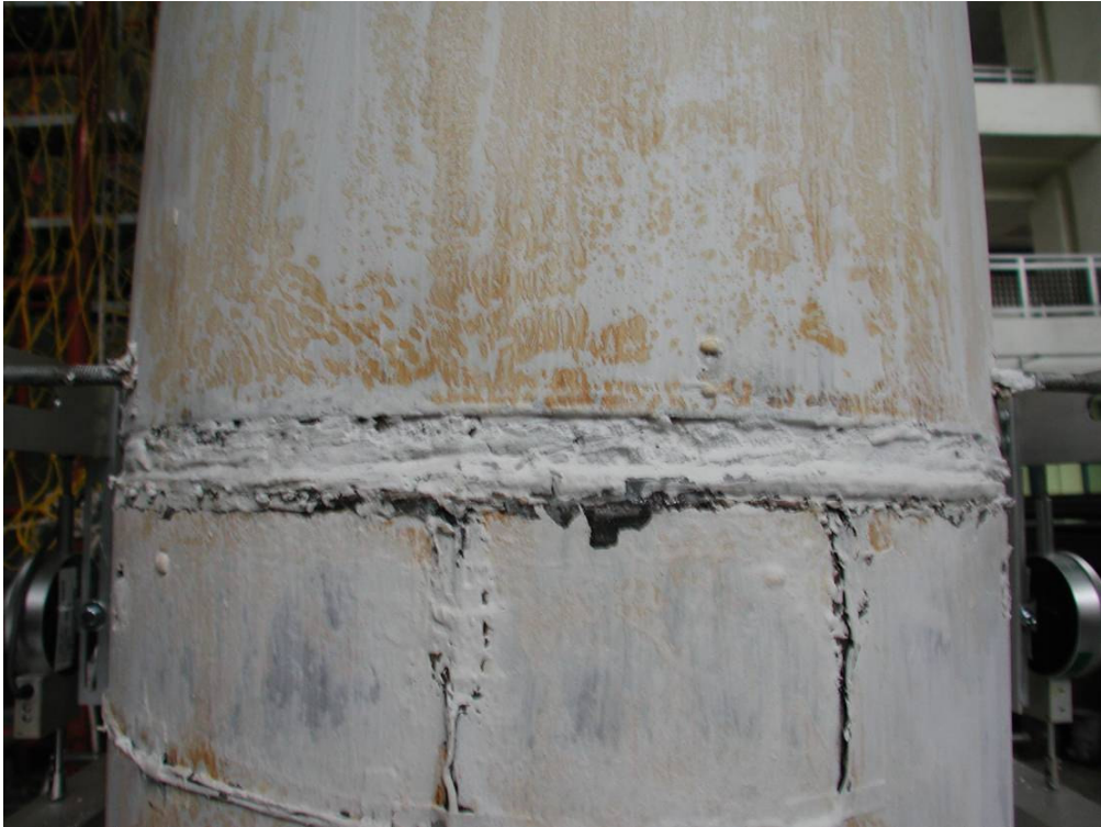
照片 3.93 試體 3 第二、三節塊間混凝土裂縫長度( \theta = +0.05 弧度)
