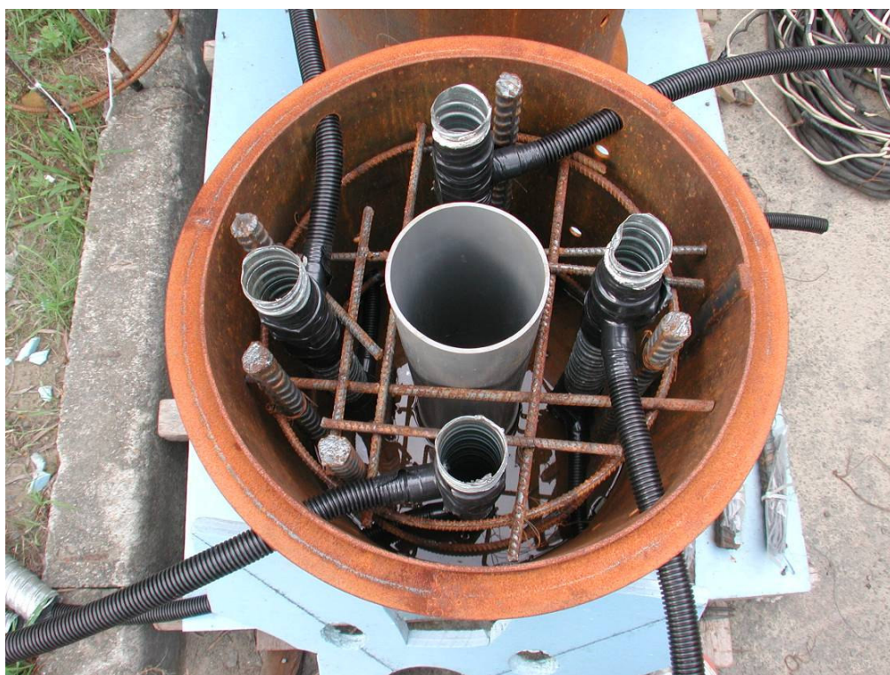
照片 3.5 鋼管混凝土節塊 PVC 管及螺紋套管定位
