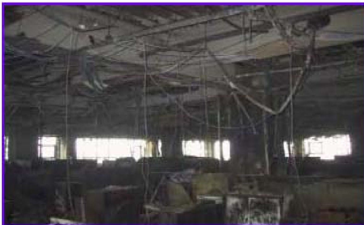
圖 2-3 防火區劃破壞延燒情形
