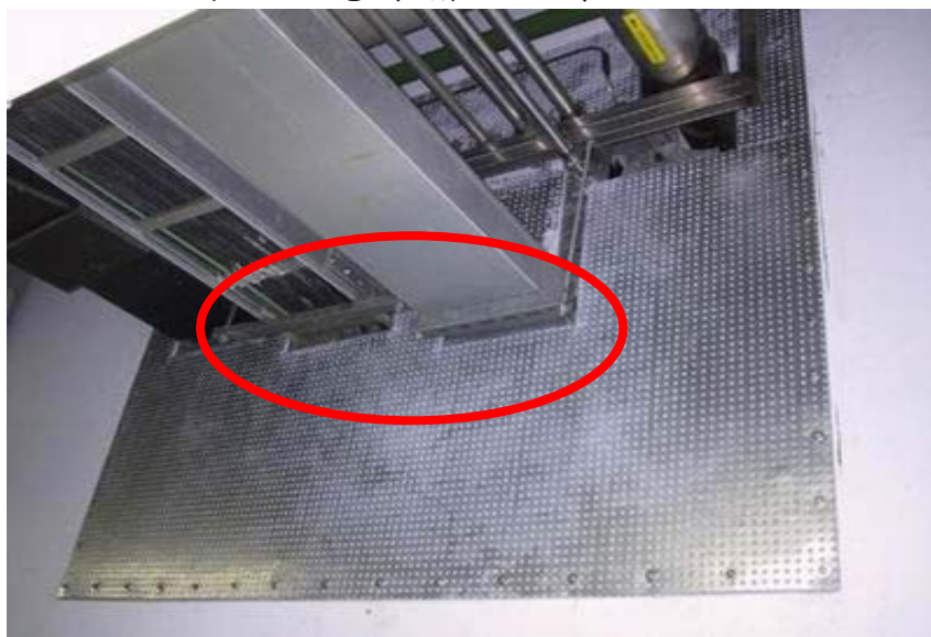
圖 5-13 電線槽阻火系統施工法
