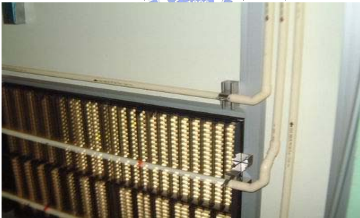
圖 5-18 裝設於回風區 VESDA 系統探測管
