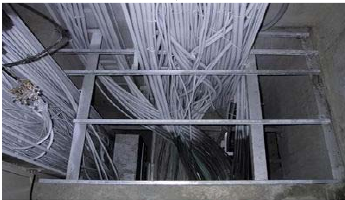
圖 5-10 管道間阻火系統施工法-支撐架施工
