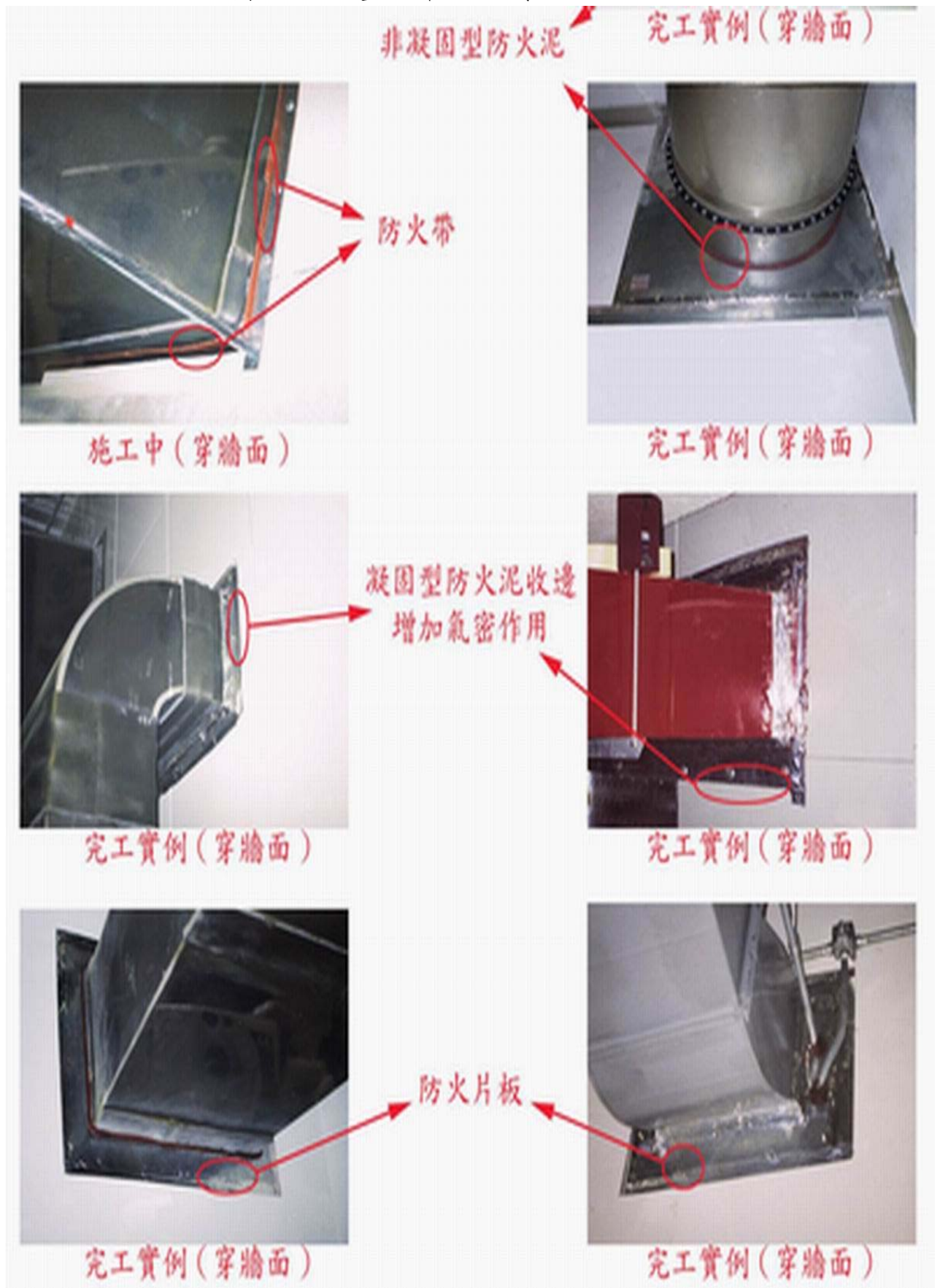
圖 5-12 大型風管阻火系統施工法
