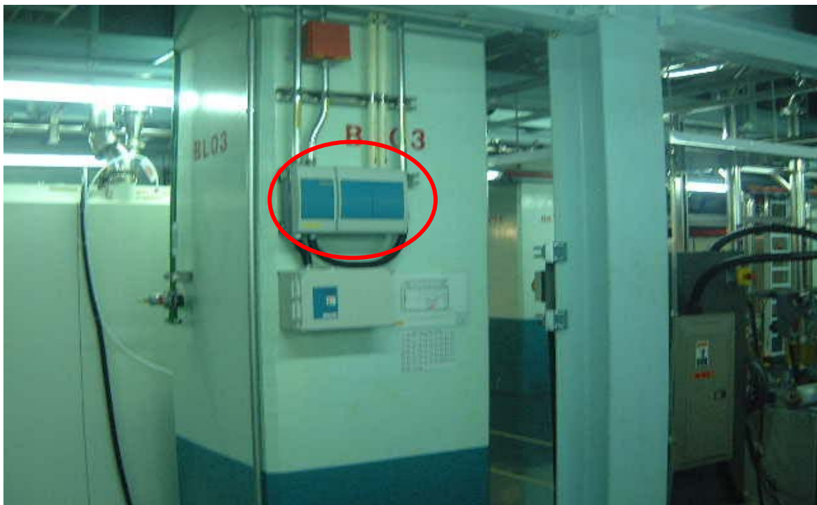
圖 5-17 裝設於潔淨室 Sub Fab 極早期偵測主機(VESDA)
