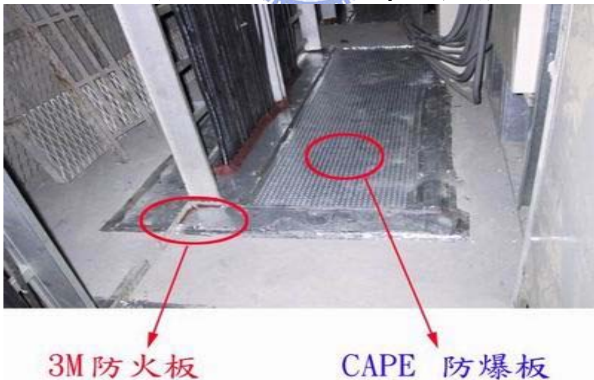
圖 5-11 管道間阻火系統施工法-cape 防爆板覆蓋
