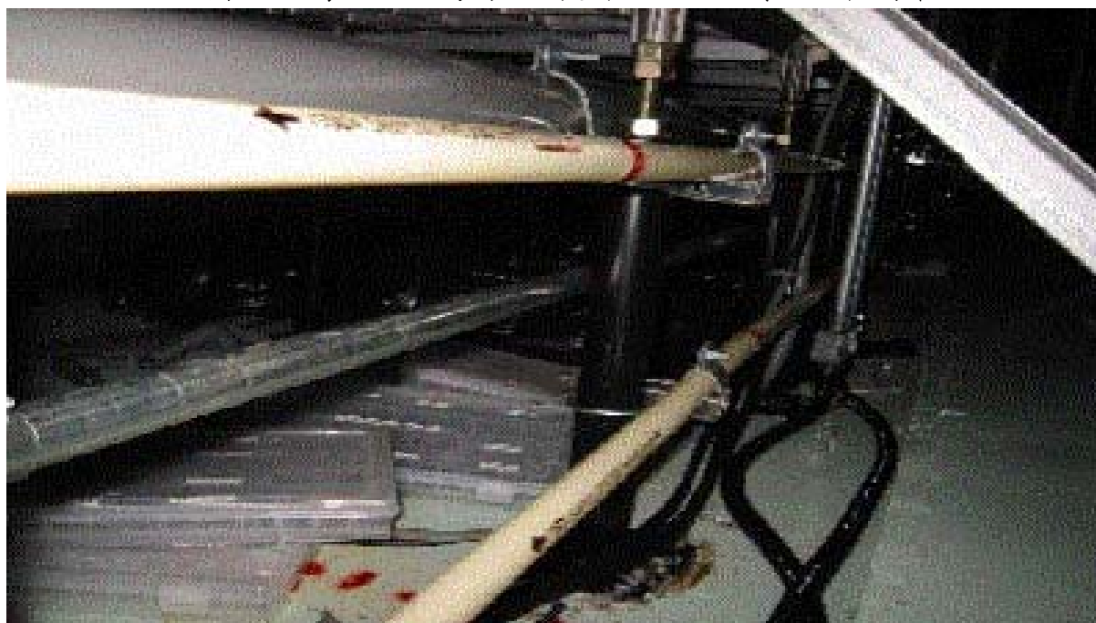
圖 5-19 裝設於高架地板下 VESDA 系統探測管
