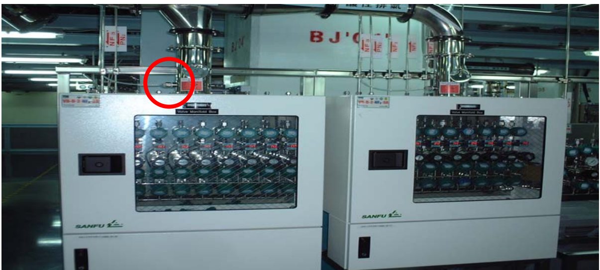
圖 5-33 氣體分流器氣體監測
