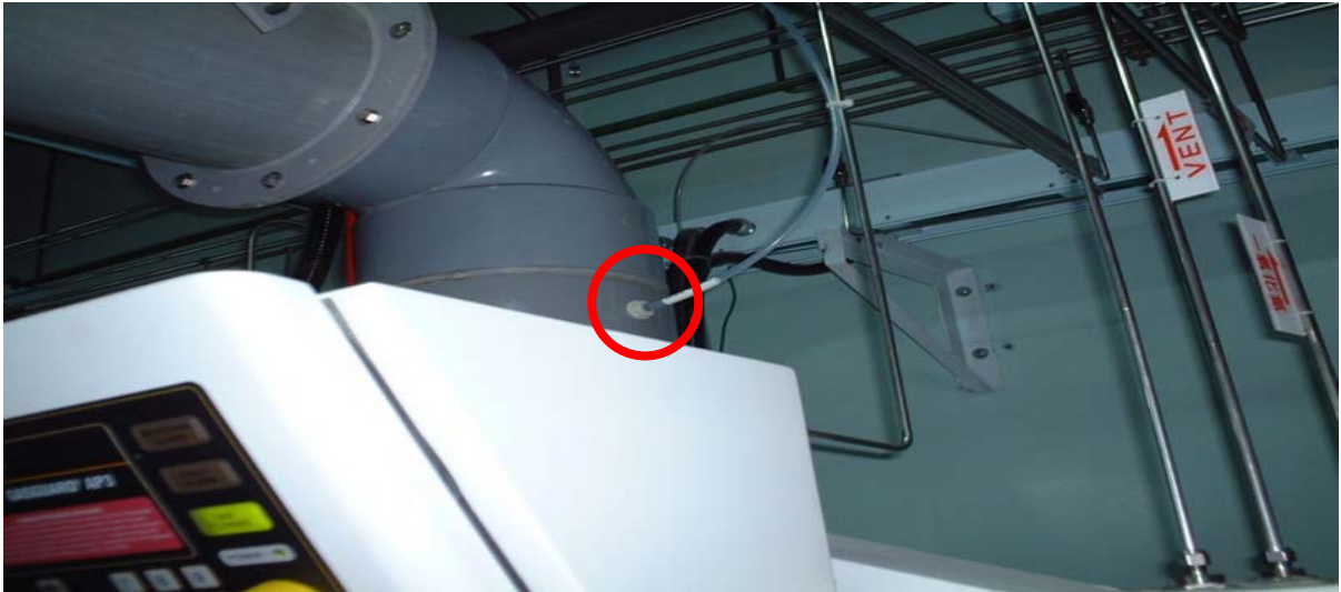
圖 5-33 氣體分流器氣體監測
