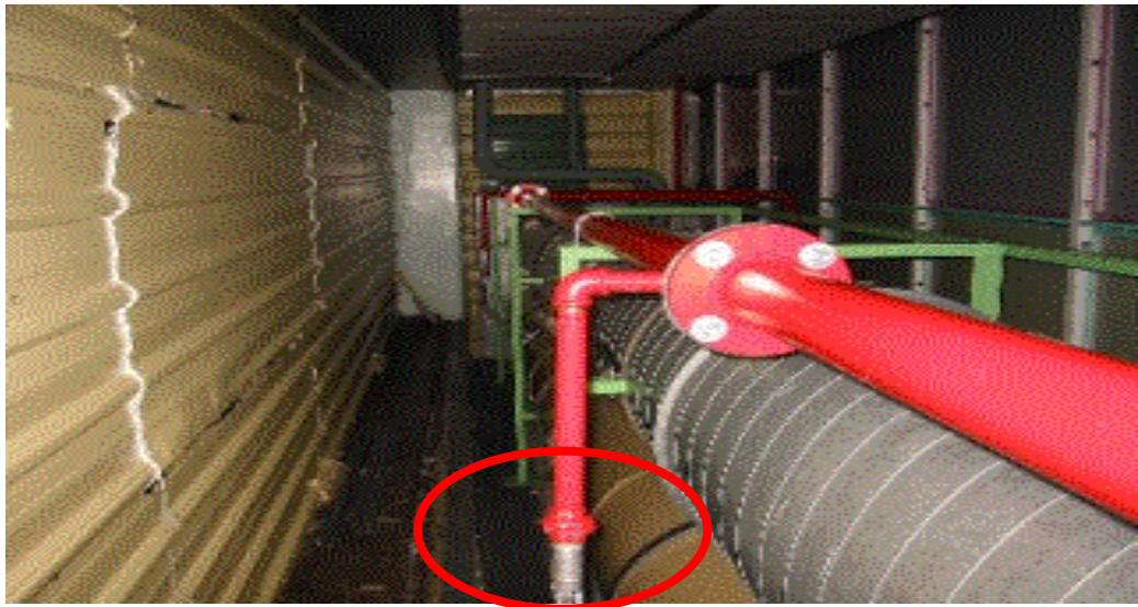
圖 5-23 有機溶劑廢氣排放管內裝設撒水頭防護圖
