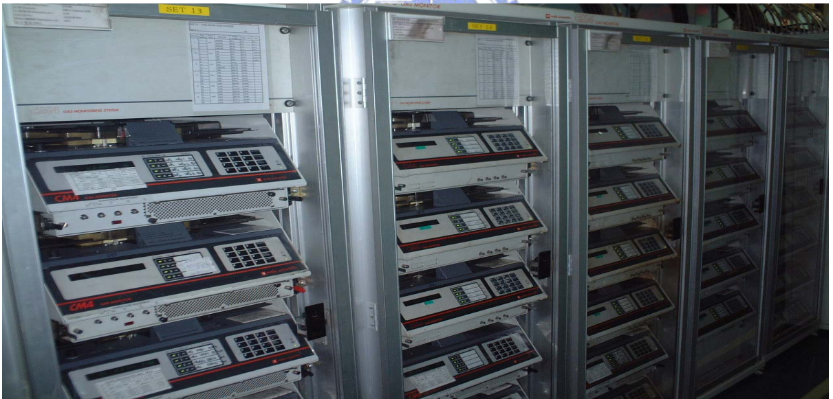
圖 5-35 氣體洩漏監測主機
