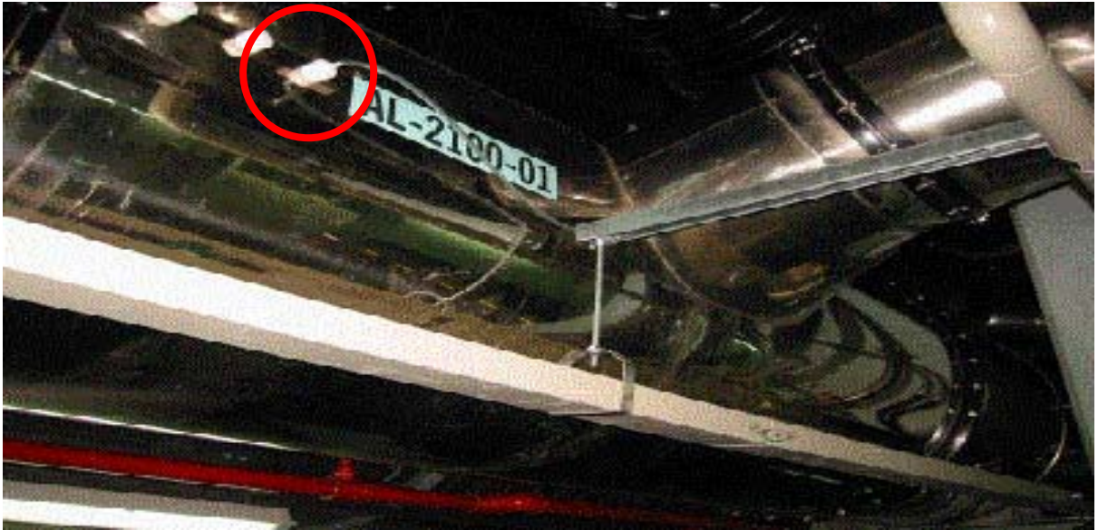
圖 5-34 排氣管路氣體監測
