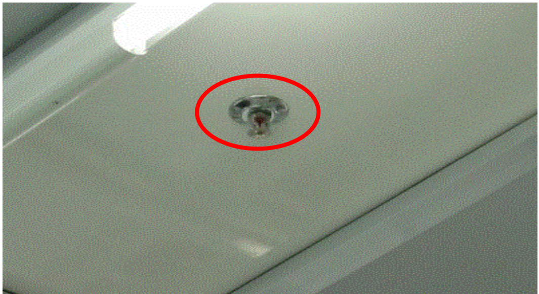
圖 5-20 裝設於潔淨室天花板上方的自動撒水系統
