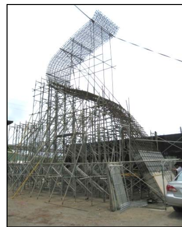
圖 3.8 試作案例二實體曲牆之二
