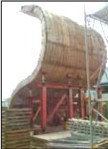
圖 3.5 試作案例二實體曲牆之一
