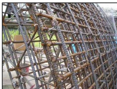
桁架鋼筋單元組配
