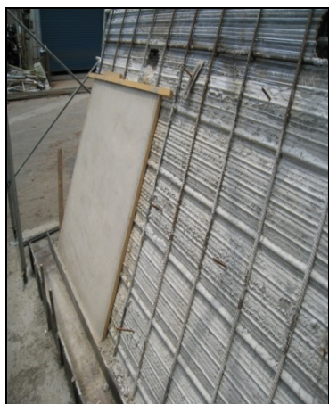
圖 3.7 試作案例二實體曲牆之一
