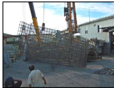
單元曲牆吊裝
