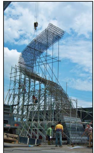
單元曲牆吊裝完成
