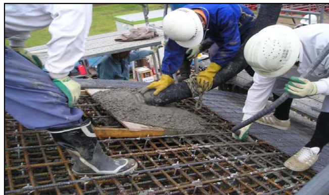
圖 2.12 曲牆混凝土分層澆置 資料來源：園部敏行(2007)
