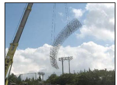
桁架鋼筋單元完成
