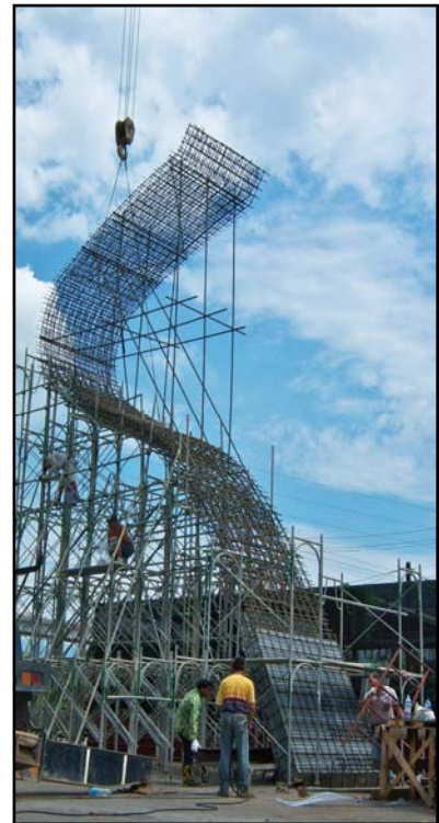
支撐及繫結檢查
