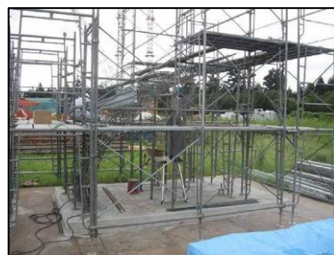
桁架鋼筋支撐架
