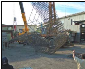
單元曲牆吊裝
