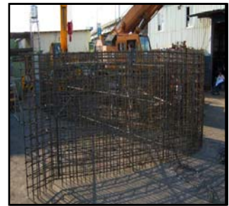
單元曲牆完成
