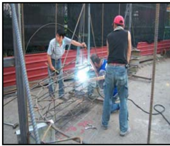
桁架鋼筋連結
