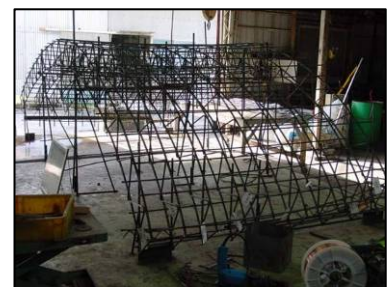
桁架樣架單元組立
