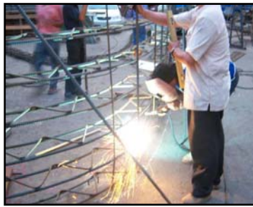
桁架鋼筋連結
