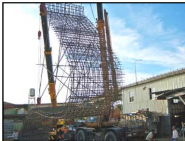
單元曲牆吊裝
