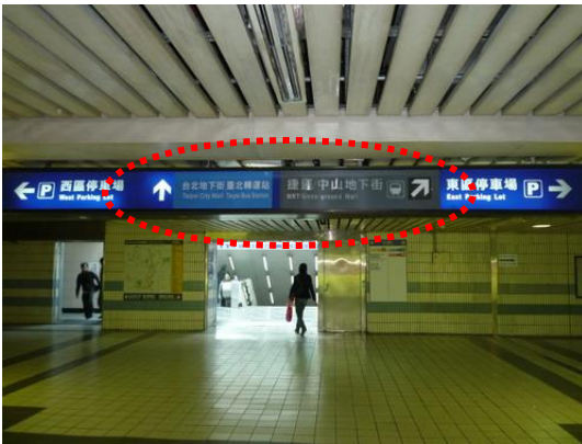
照片 21 標示資訊未整合且照明不足(98.12.04)
