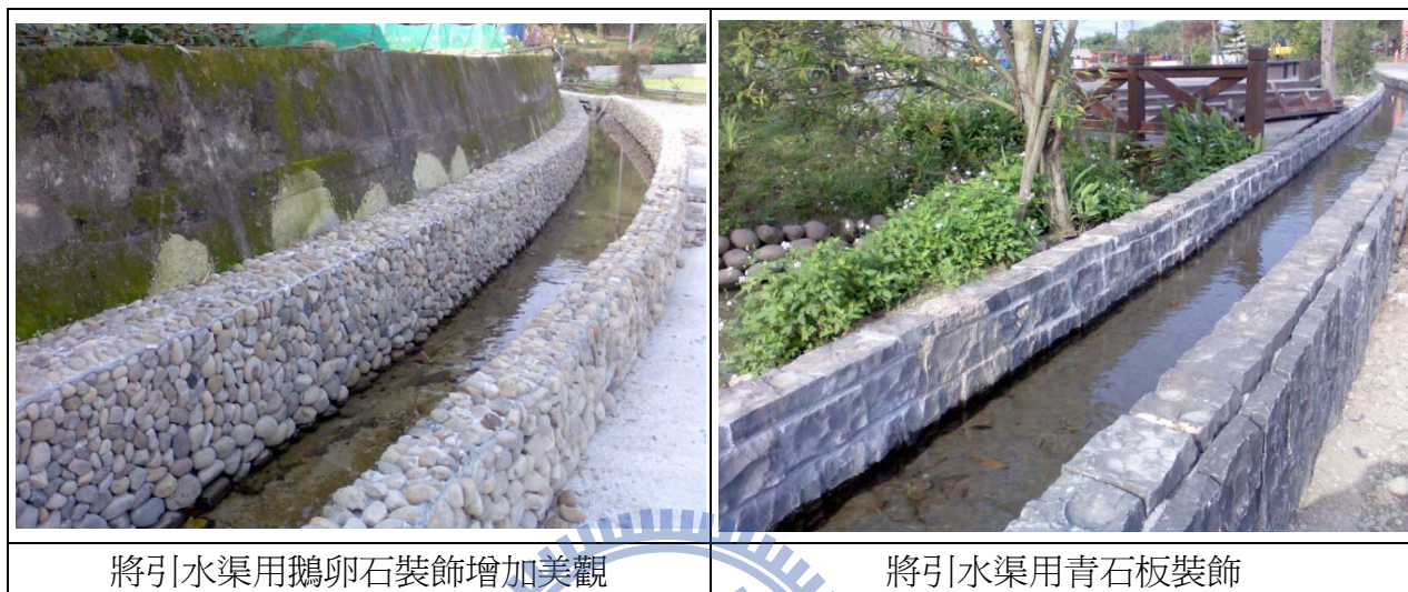
圖 4-2-5 南埔三大圳整修與景觀工程
