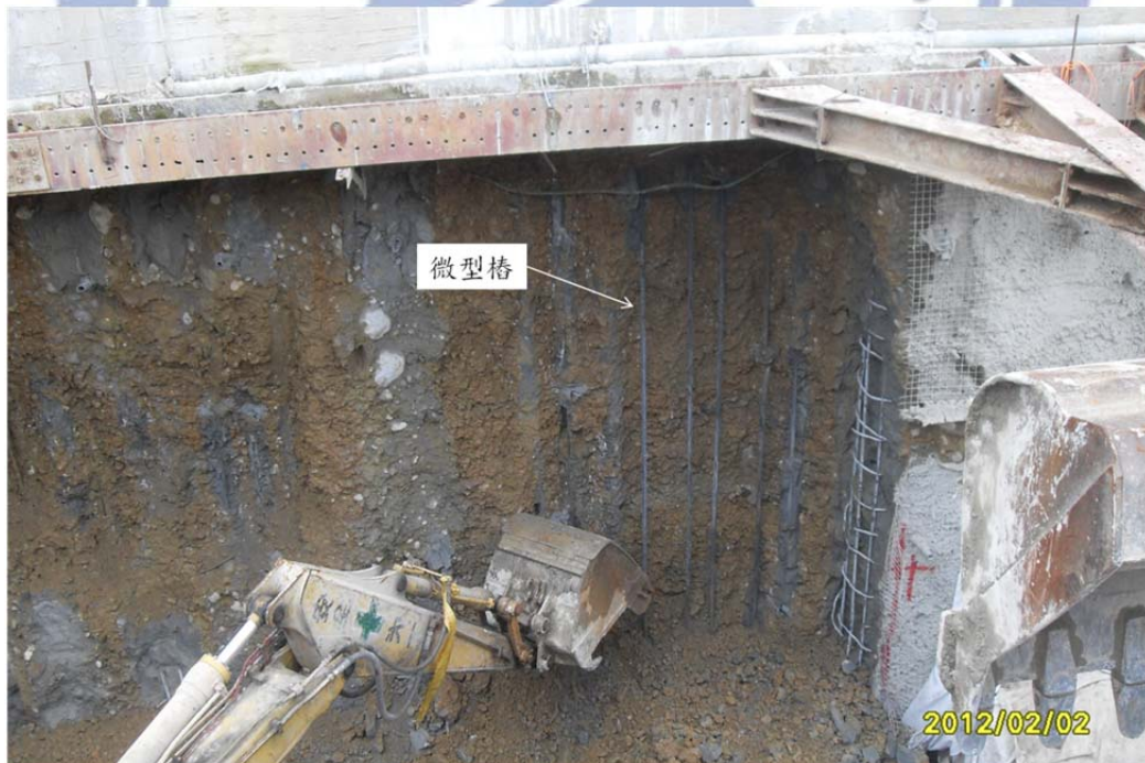
圖 5.3 怪手破除預壘樁後的微型樁準備開挖聯絡通道
