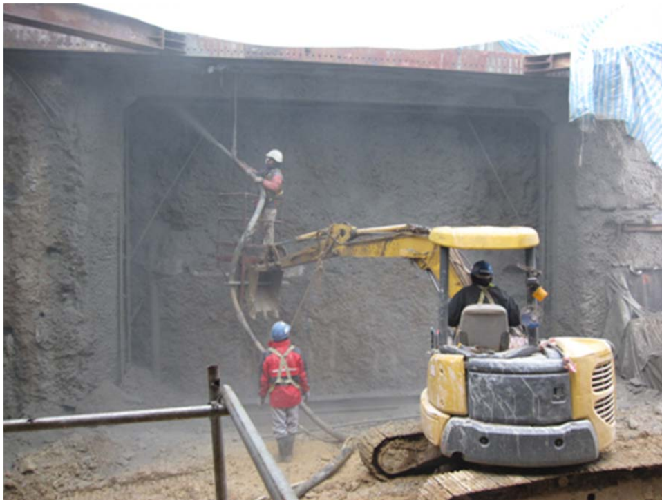
圖 5.6 開挖區頂部施作噴凝土
