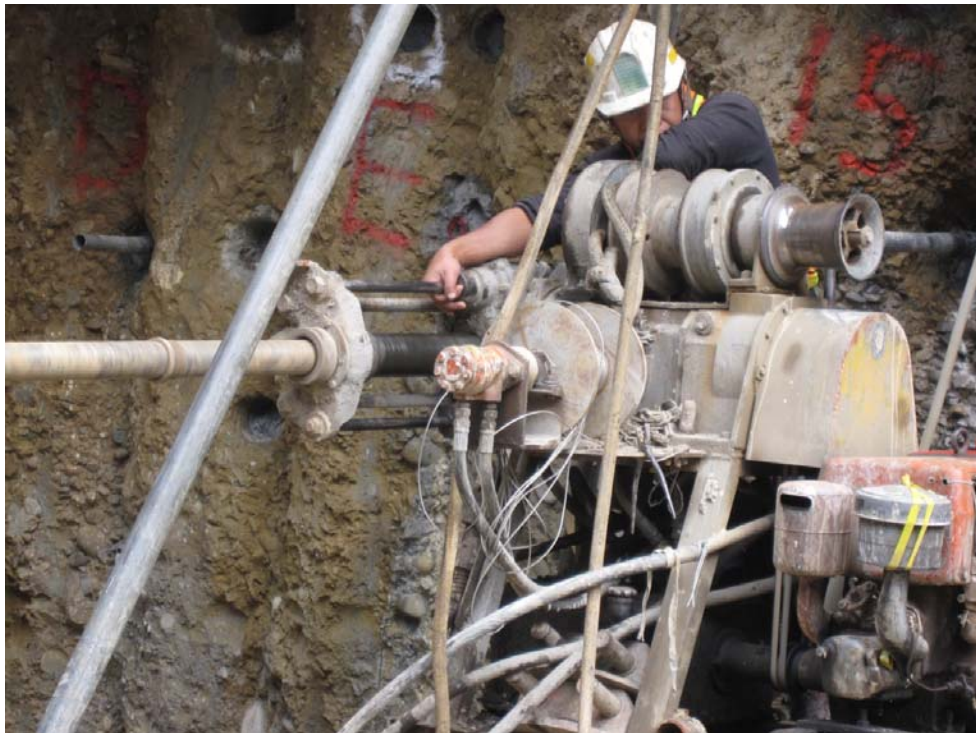
圖 4.21 施工人員正在進行鑽孔取樣作業
