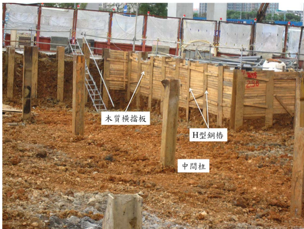
圖 3.15 地下廣場開挖區周邊之 H 型鋼樁擋土措施
