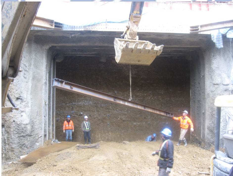
圖 5.5 怪手吊放鋼梁準備組立隧道斷面鋼支堡
