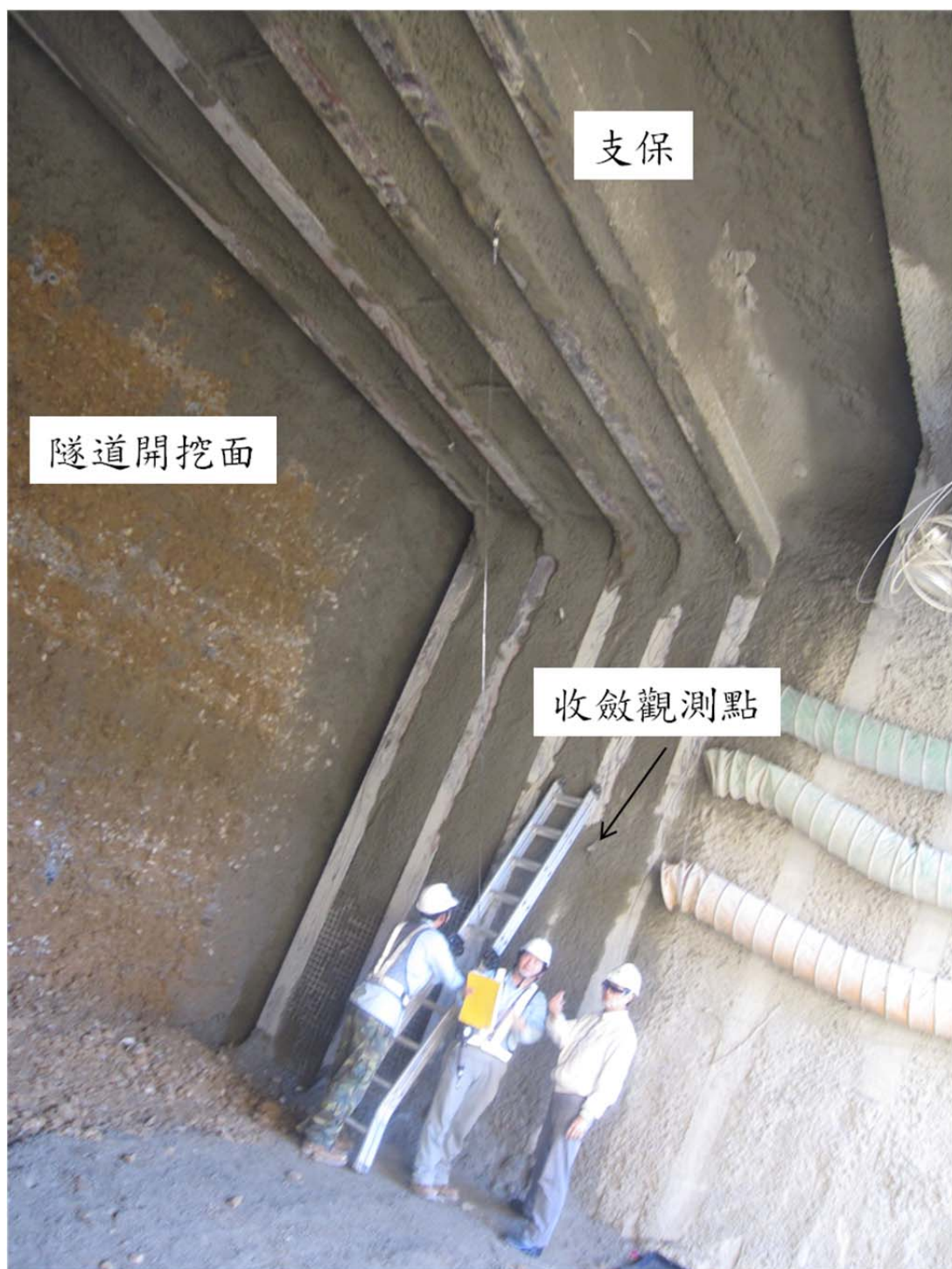
圖 3.25 施工單位於隧道內量測隧道之收斂
