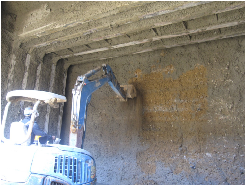
圖 5.4 怪手開挖隧道壁面
