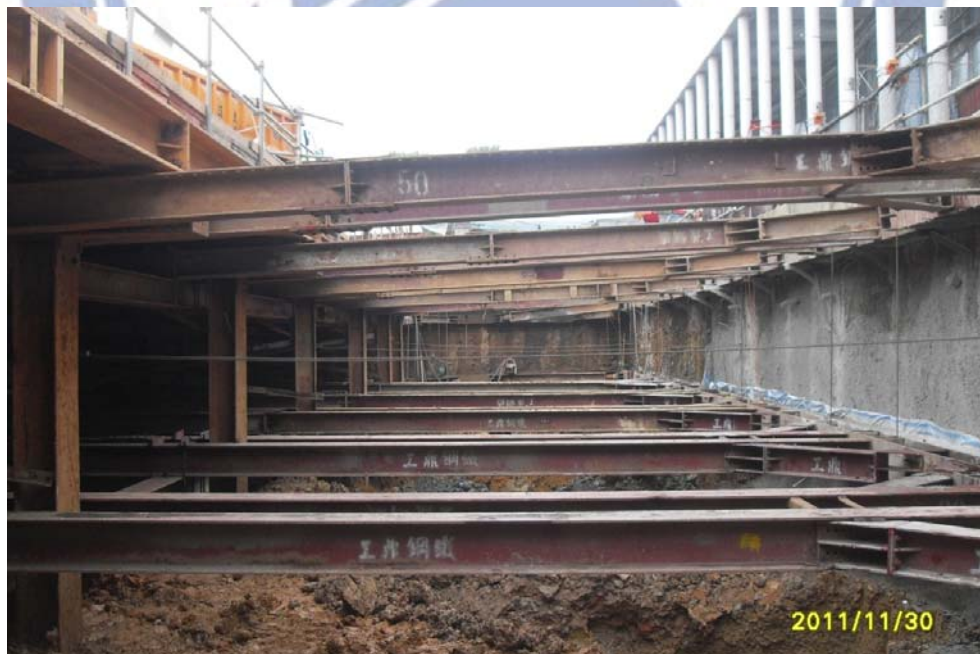
圖 3.16 開挖地下廣場時所架設的兩層水平鋼梁支撐
