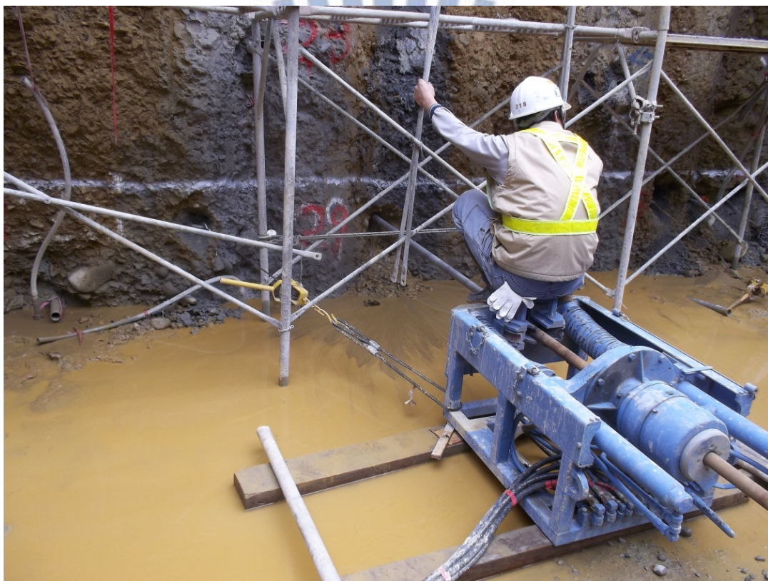
圖 4.19 試水孔鑽孔作業
