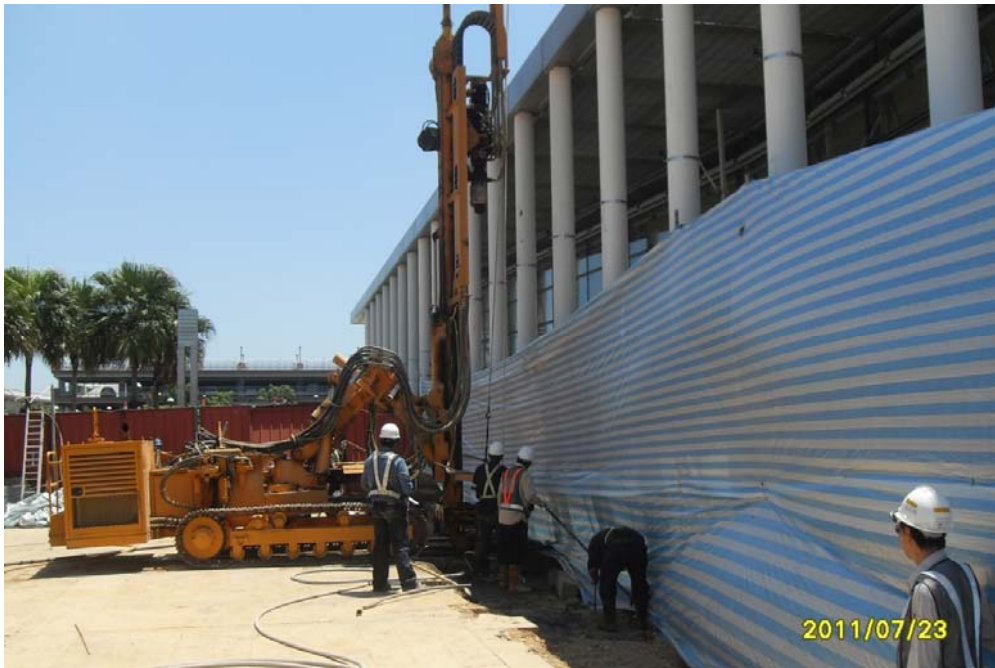
圖 3.13 地下廣場開挖區與高鐵桃園站間施作微型樁 (摘自泛亞工程, 2011)
