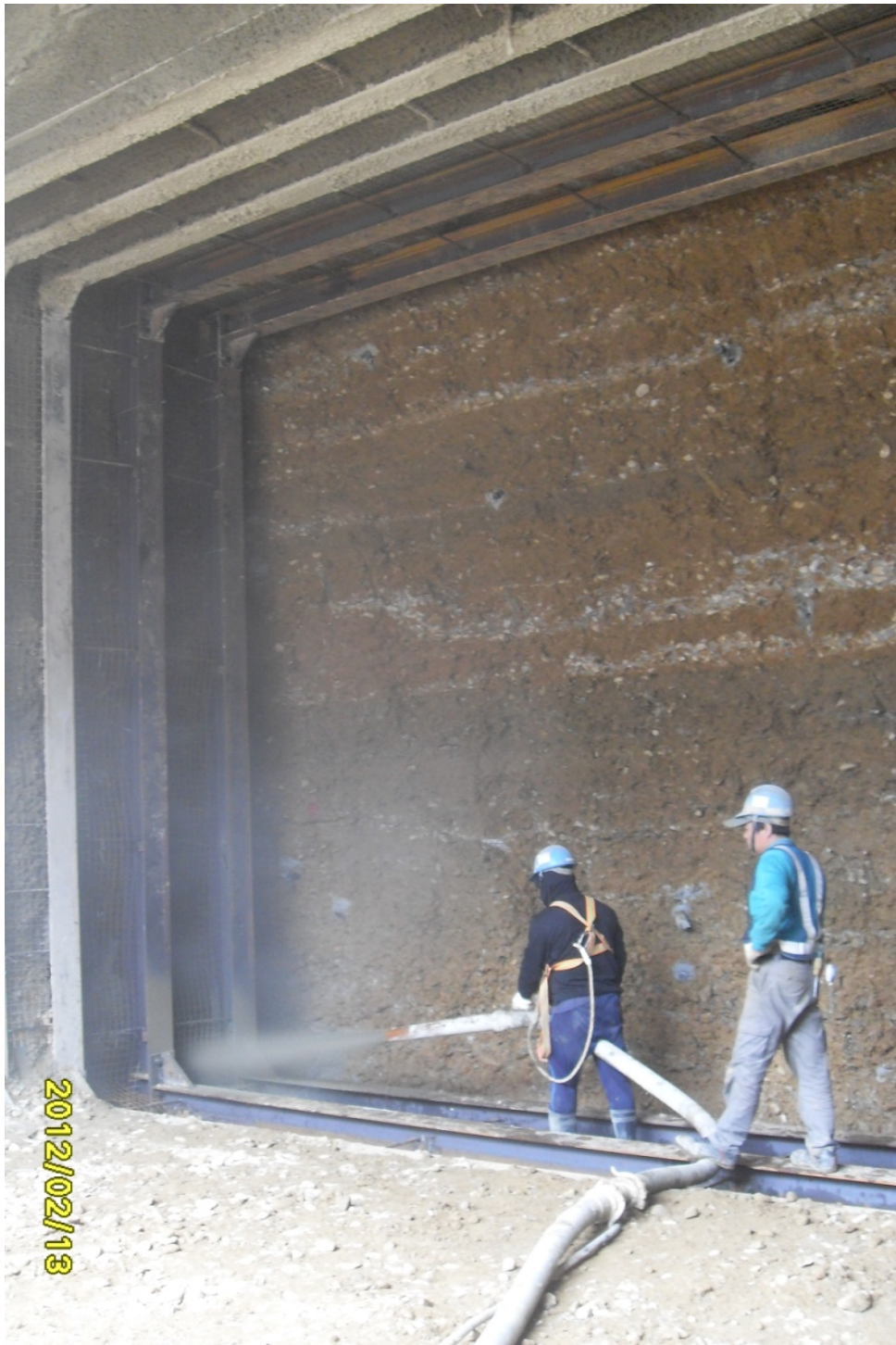
圖 5.12 第 10 開挖斷面左下方施作噴凝土作業
