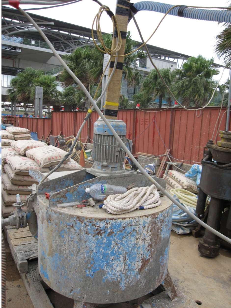
圖 4.3 漿液快速攪拌機
