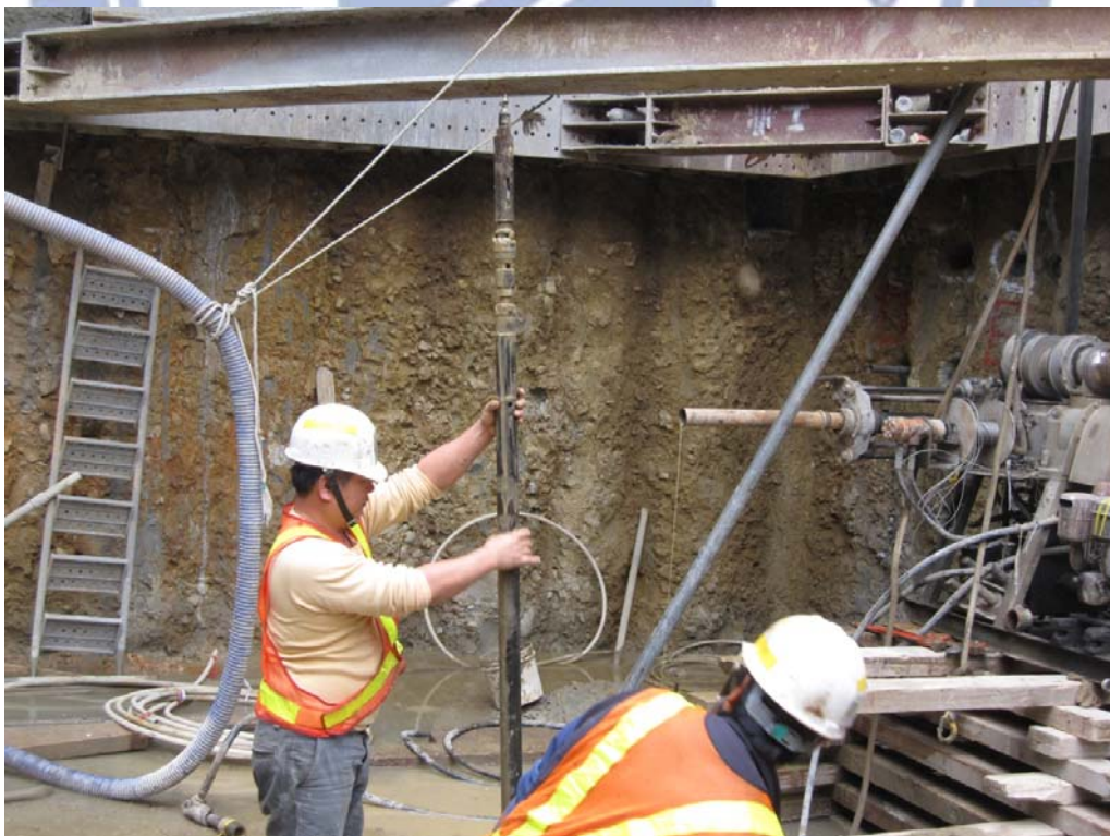
圖 4.22 施工人員正在將試體取出
