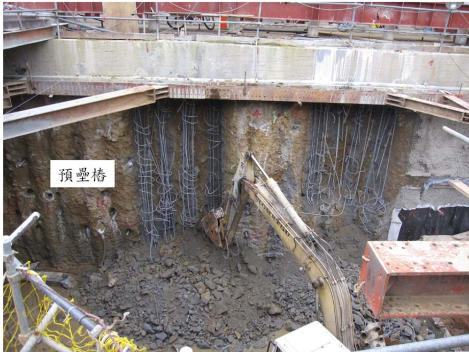
圖 5.2 怪手破除預壘樁準備開挖聯絡通道開挖
