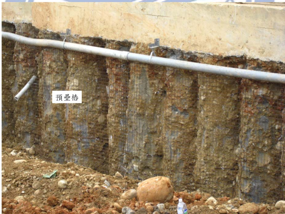
圖 3.14 微型樁後近車站前緣所設置支預壘樁
