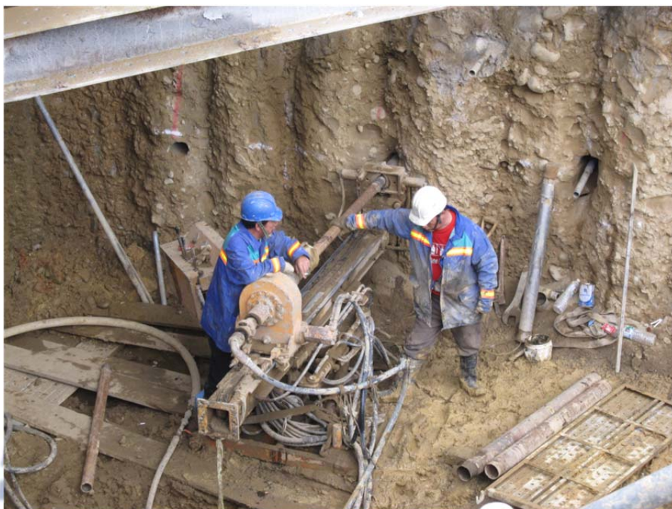
圖 4.10 鑽機進行水平鑽孔作業
