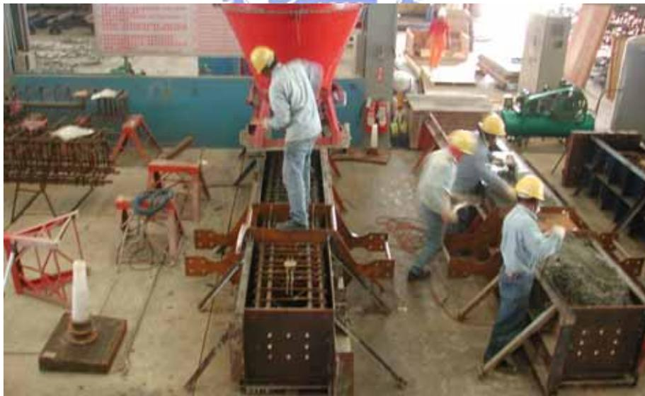
照片 3.2 試體 1 與試體 3 於預鑄廠灌漿全景
