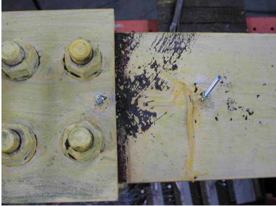
照片 3.49 試體 4 上側削切蓋板端部之梁翼板降伏 ( \theta = 0.06 弧度)
