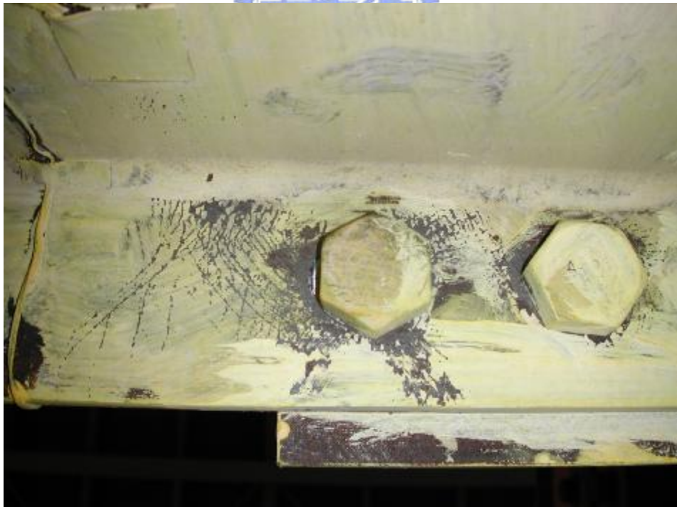
照片 3.52 試體 4 梁翼板內側及腹板降伏 ( \theta = -0.06 弧度)
