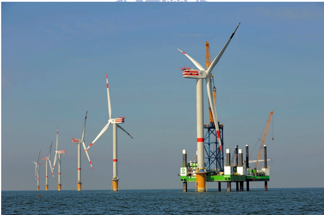
圖 2-7 自升式平台船安裝離岸風機
