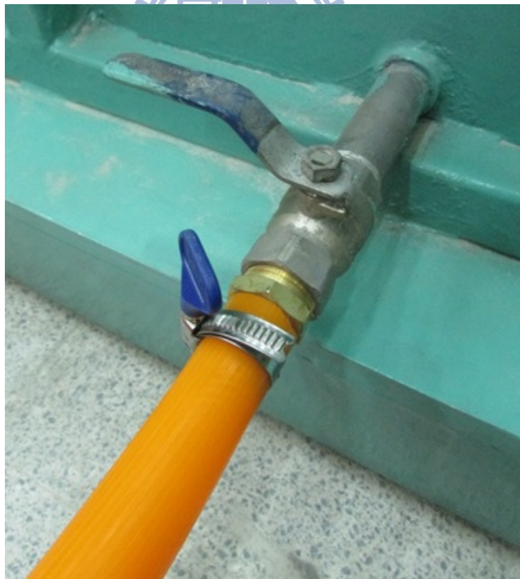
圖 4-24 進/出水口接上進水水管
