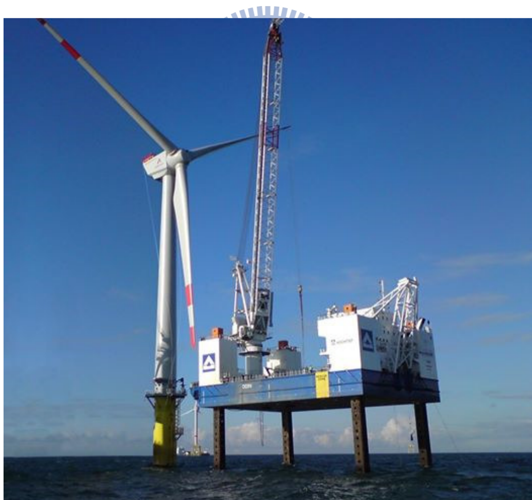
圖 1-2 自升式安裝平台船安裝離岸風機
