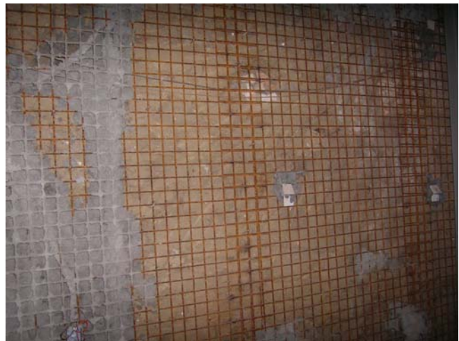
圖 22：風貌保存之牆面補強
