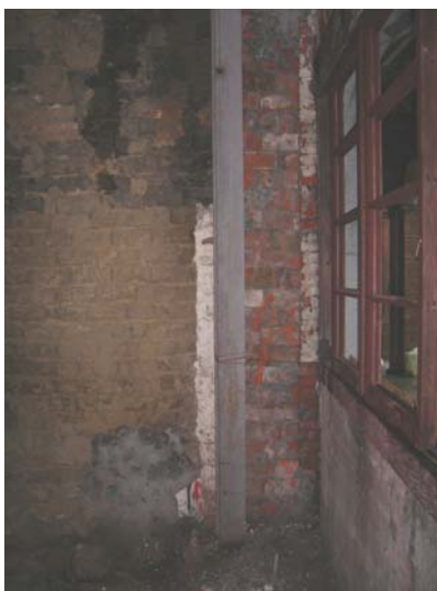
圖 21：風貌保存之結構補強
