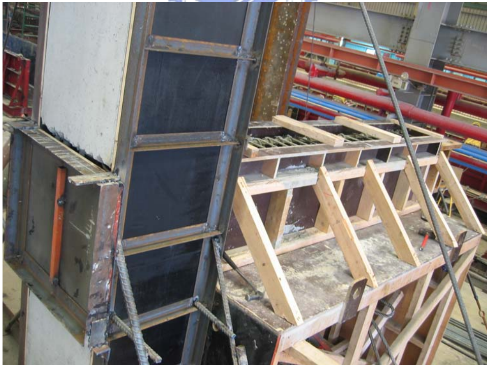
(b) 梁柱接頭區及 SRC 梁頂部混凝土第二次灌漿及封模情形
