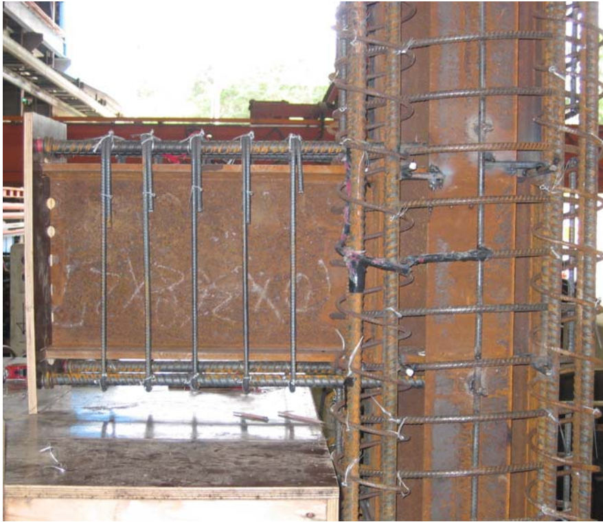
(a) SRC 梁柱接頭區未灌漿前之情形
