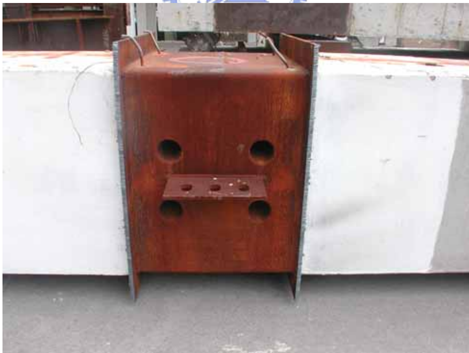
照片 3.24 將損壞鋼板切下並磨平
