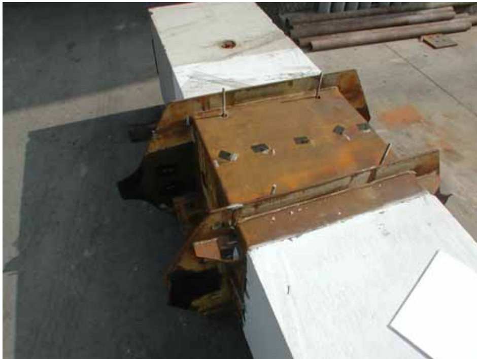
照片 3.23 削切鋼板替換前情形
