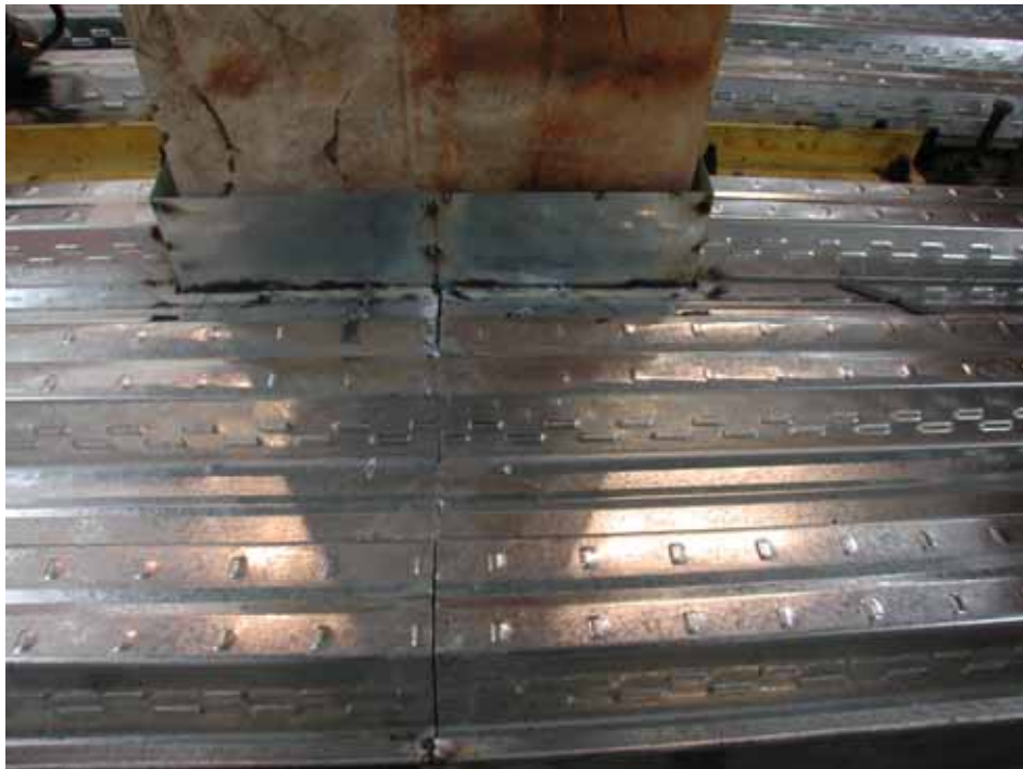
照片 3.29 鋼承版在柱中心處分開
