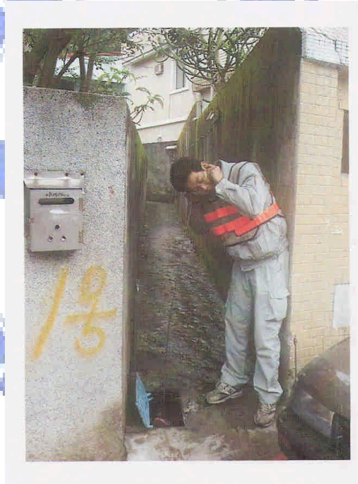
圖 3.3 閘栓及水表聽音（盛安資訊股份有限公司，2006）
