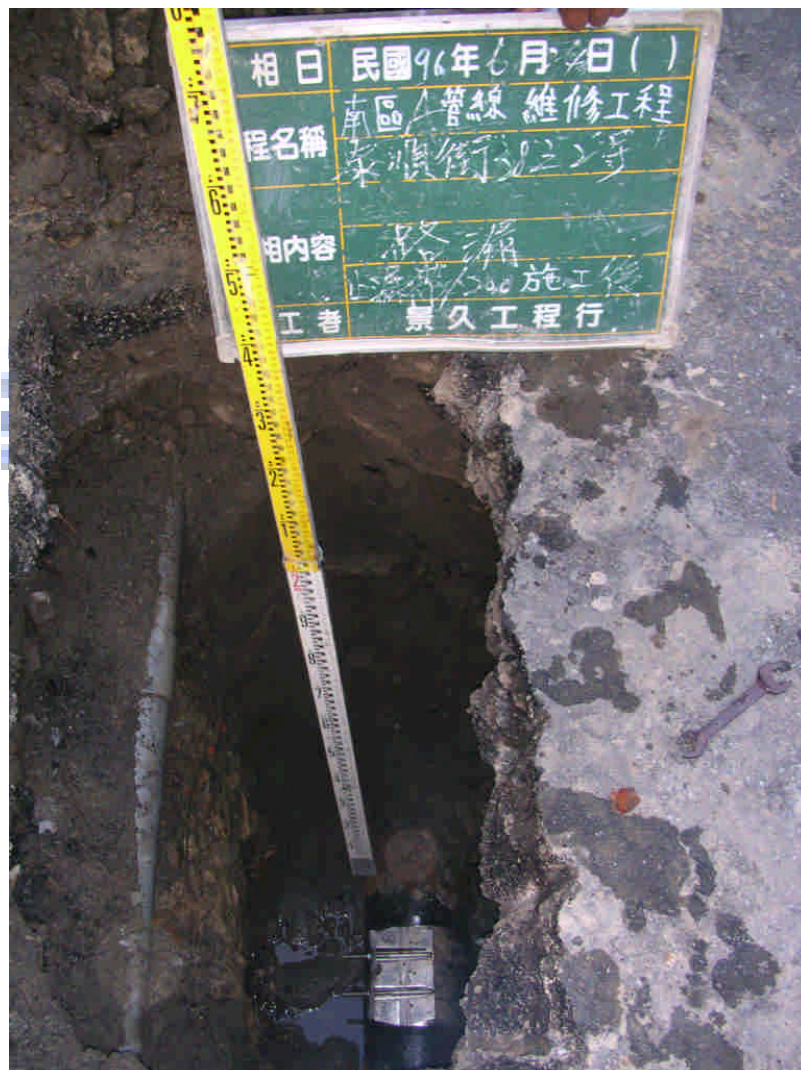
圖 5.13 B1 測點之現地開挖狀況
