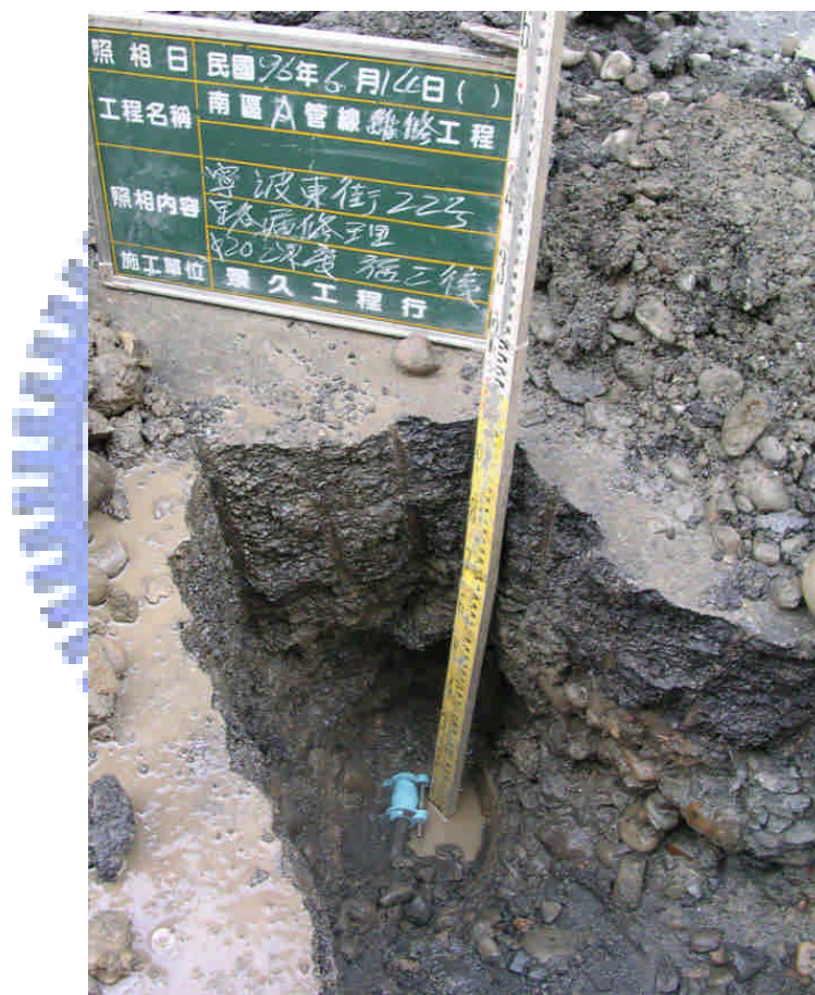
圖 5.25 D1 測點之現地開挖狀況
