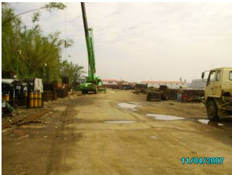
圖 2 鋼筋場硬體設置現況
