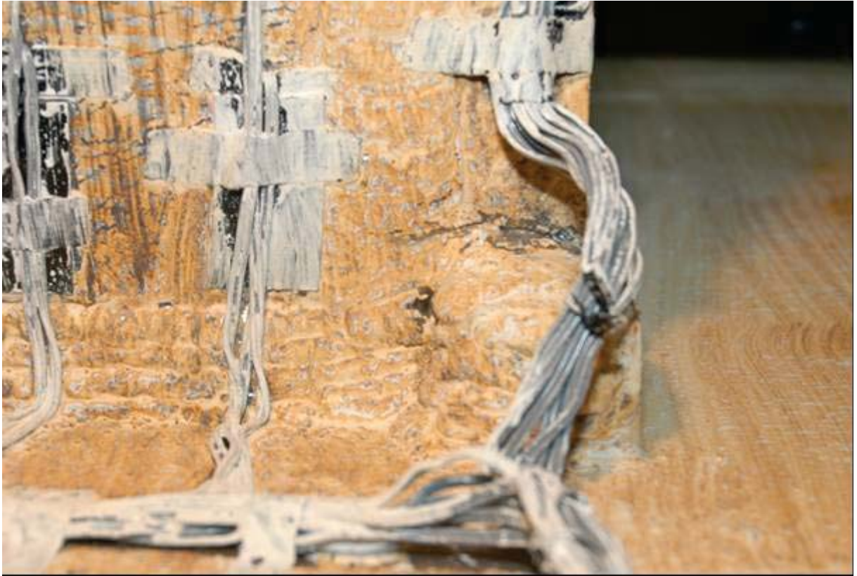
照片 4.55 試體 FDWS3 下翼梁柱接頭焊道上方母材裂痕 ( \theta = +1.0\% 弧度)
