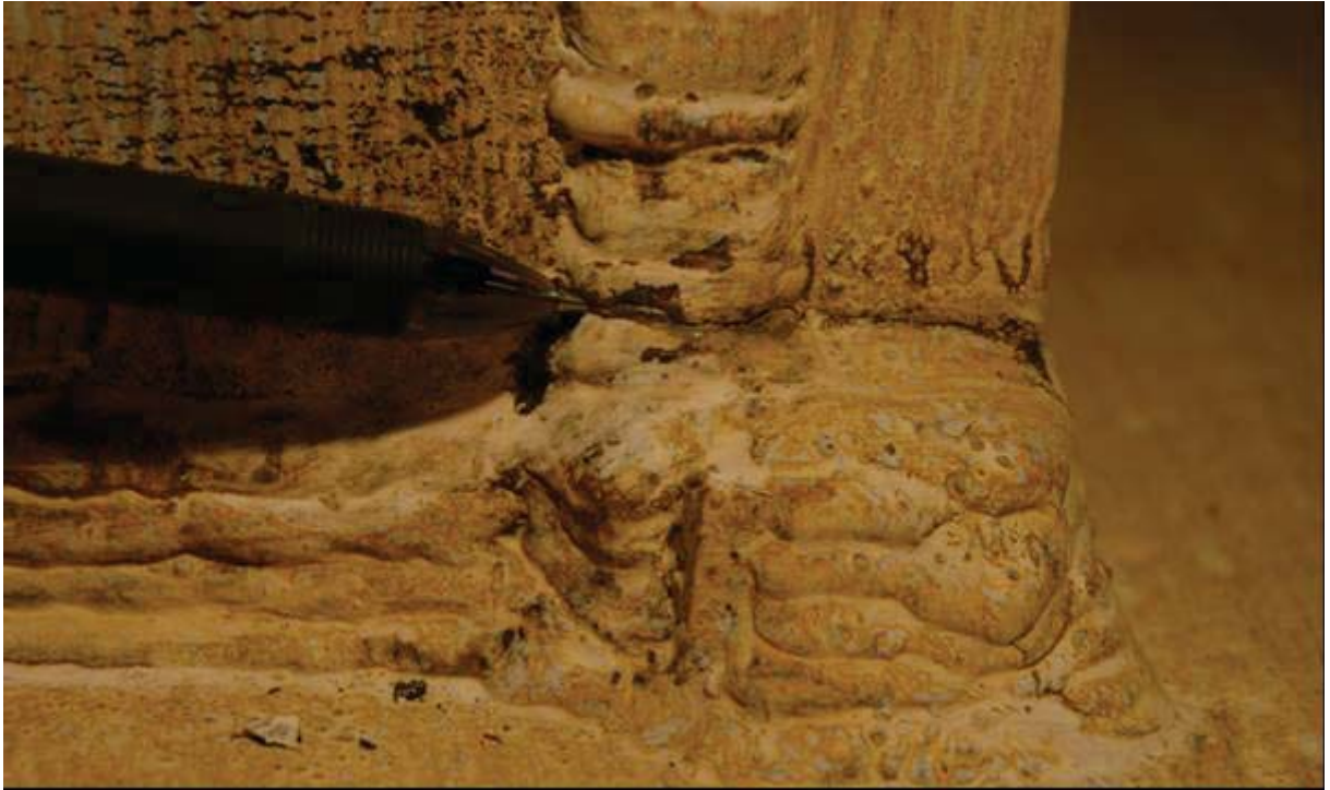
照片 4.53 試體 FDWS3 上翼梁柱接頭焊道上方母材裂痕 ( \theta = -1.0\% 弧度)
