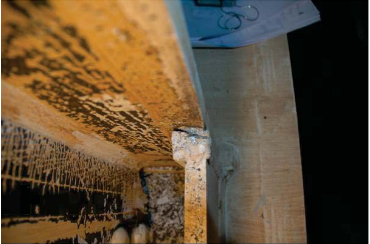
照片 4.51 試體 FDWS3 加勁板與梁接之焊道端部裂痕 ( \theta=4.8\% 弧度結束)
