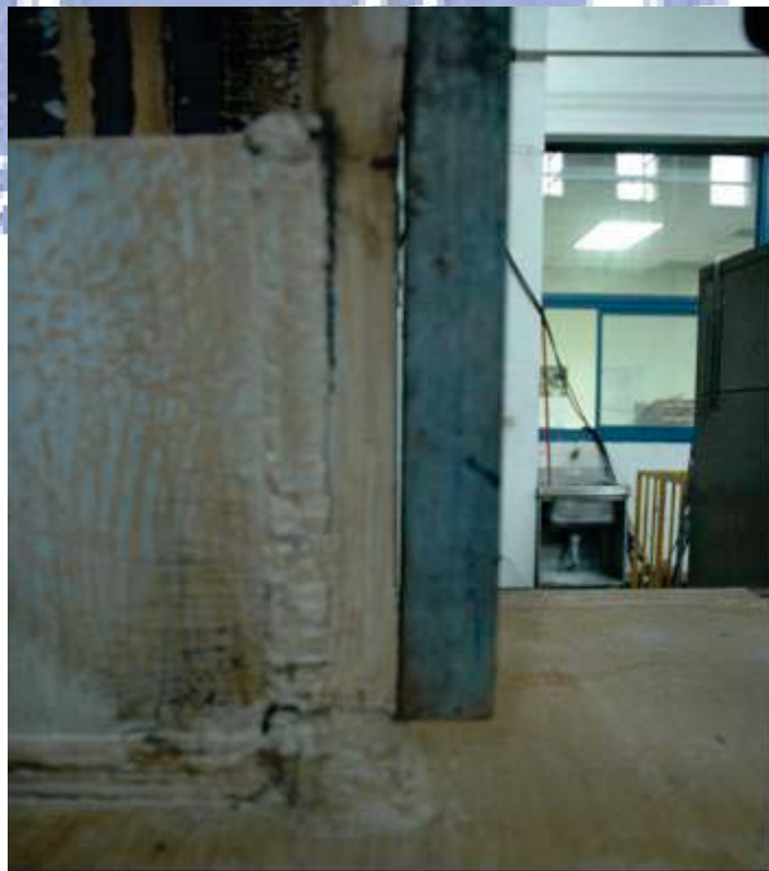
照片 4.54 試體 FDWS3 梁上翼板於加勁板端部挫屈 ( \theta = +1.0\% 弧度)
