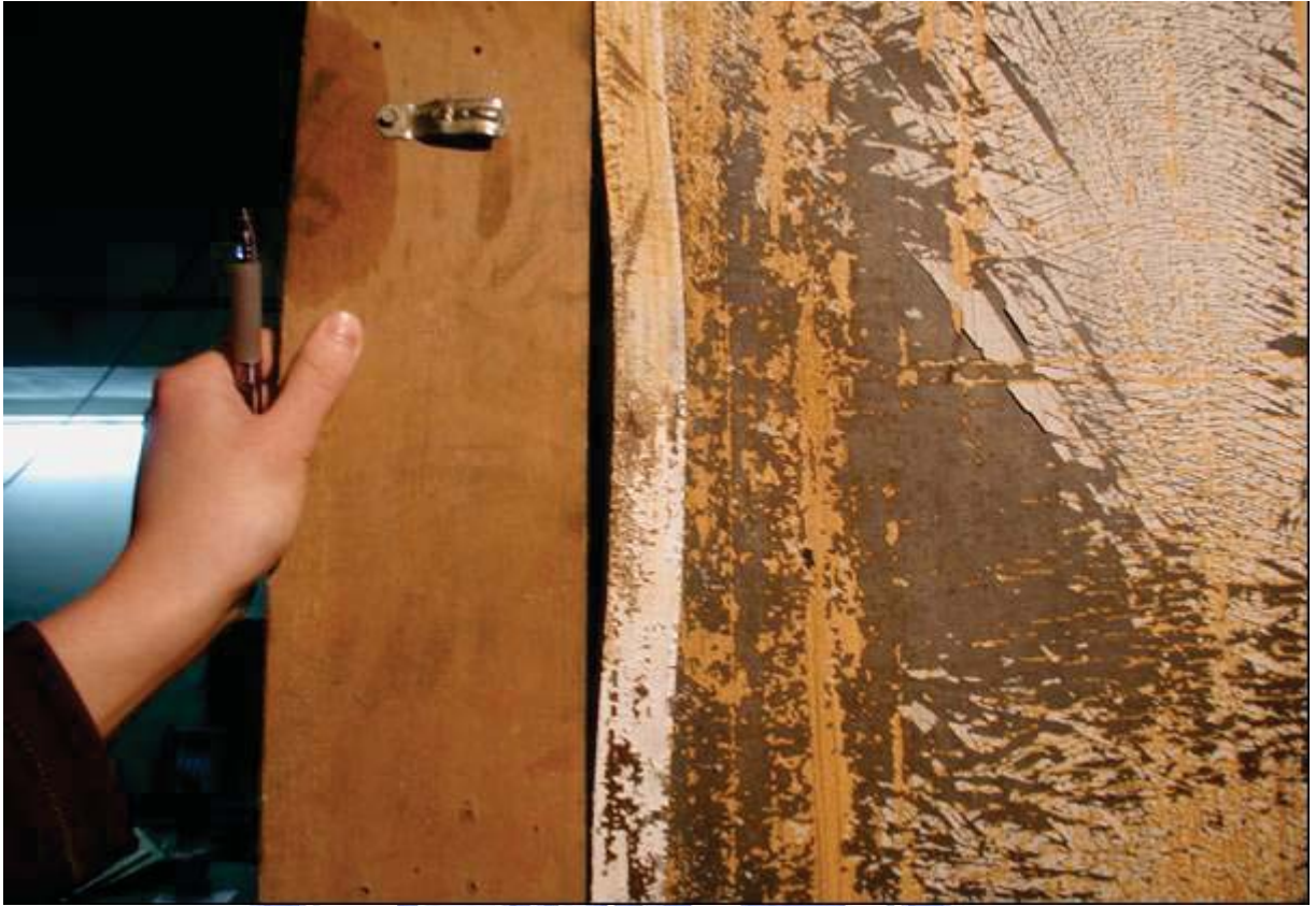
照片 3.83 試體 IFS5 第二次試驗下翼板之挫屈情形
