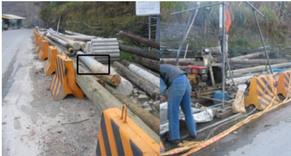
圖 3-9 X2 孔鑽探前與鑽孔施作情形
