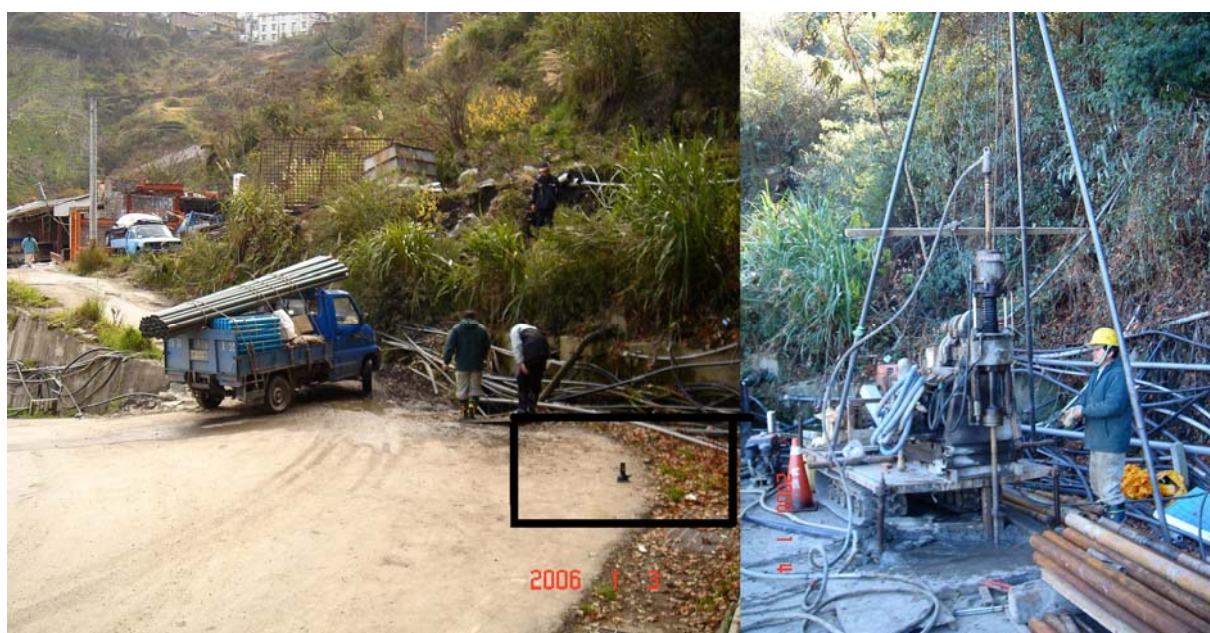
圖 3-3 N1 孔鑽探前與鑽探施作情形
