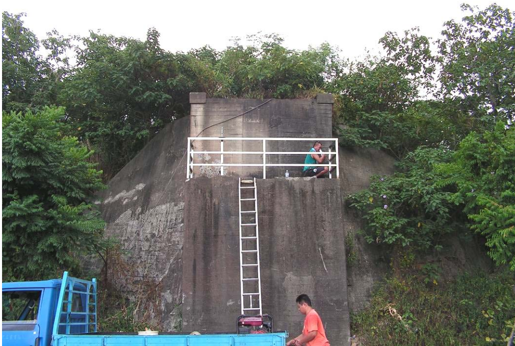
圖 6.4-10 施工完成照片 (B)
