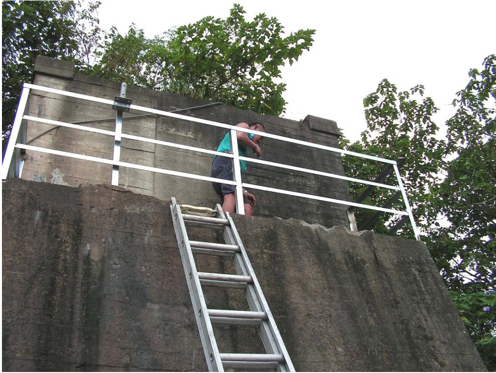
圖 6.4-9 施工完成照片 (A)
