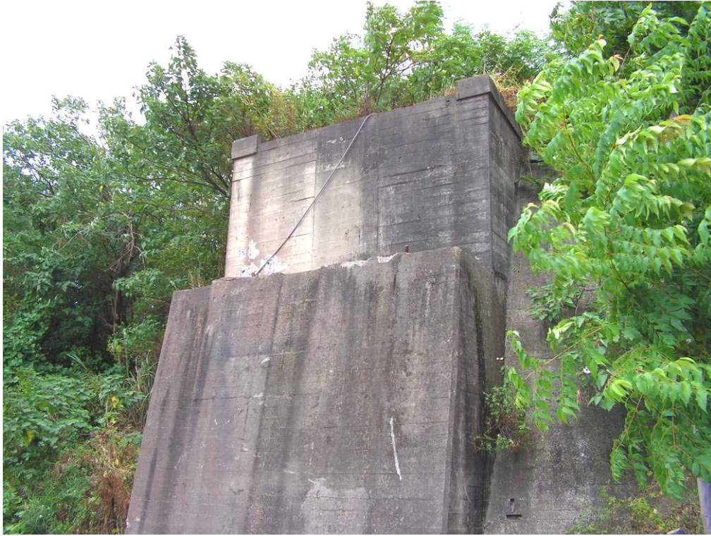
圖 6.4-8 未施工前位置照片
