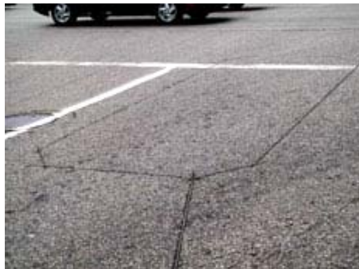
圖 3.3.1-2 單迴圈偵測器實際佈設情形 2
