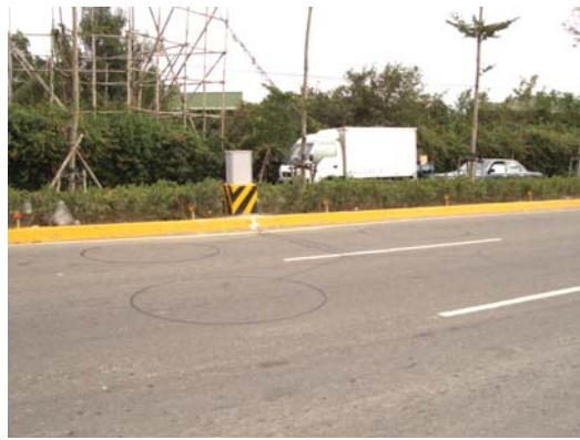
圖 3.3.1-1 單迴圈偵測器實際佈設情形 1
