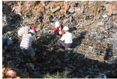
圖 6 試體修飾及紮筋
