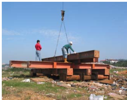
圖 21 反力架吊放鋼樑
