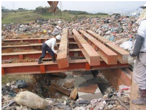
圖 10 反力架鋼樑吊放
