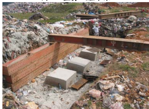
圖 9 架設反力牆
