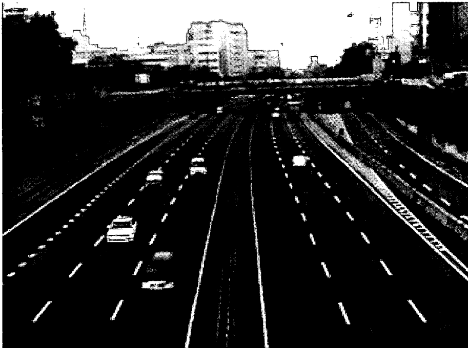
(f) 高速公路，雙向六車道。
