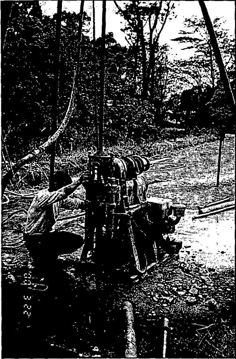
圖 5.11 沖洗鑽探法鑽孔
