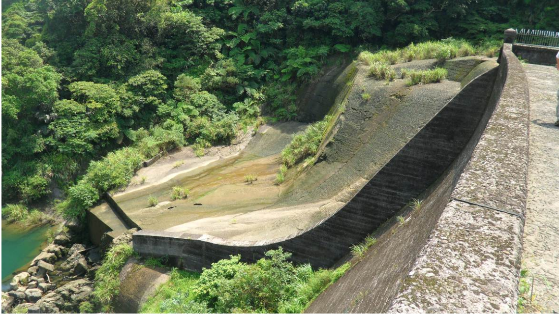
圖 5-26 西勢水庫溢洪道現勘照片(民國 101 年 6 月現勘)
